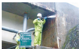
塩分洗浄(道路構造物)
