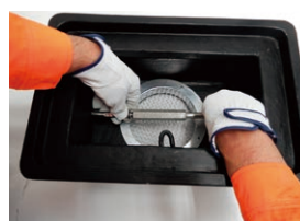
横張り軸金具取付
