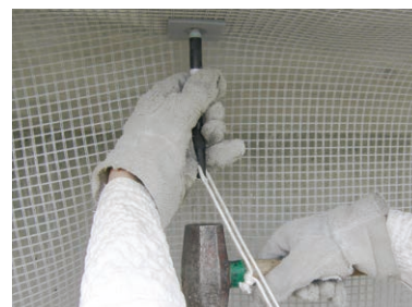
打ち込み棒とハンマーで打設
