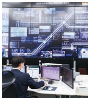
■道路管制センター
