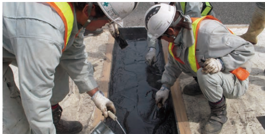
ジョイントを設置する面にマトリクス502バインダーを丁寧に塗布する
