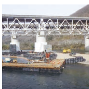
■山陽道 旭川橋 橋脚補強工事状況
