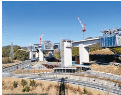
■新名神高速道路(成合第一高架橋)
