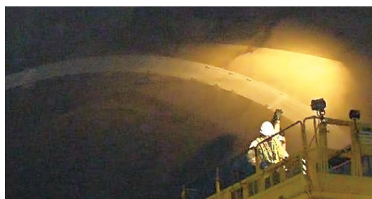
トンネルの曲面にぴったりフィット
