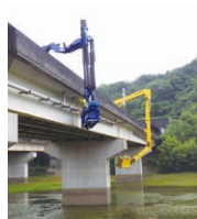
■橋梁点検車による点検
