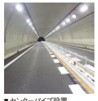
■センターパイプ設置(試行設置)
