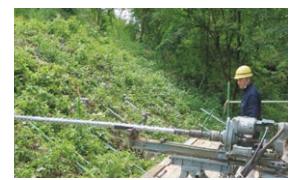
■SDPR工法の施工状況(羽根径72mm)
