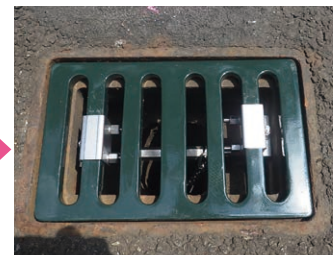
施工後の柵蓋 ※1
