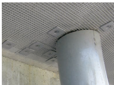
排水管周辺も施工が容易
