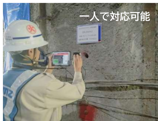
吹付けコンクリート厚さ検測
