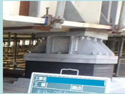
耐震補強工事一例
