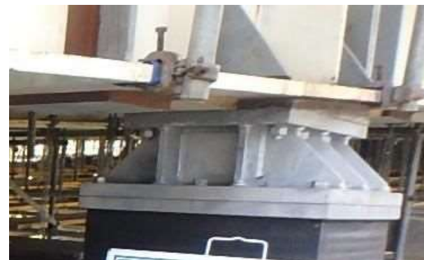
《更なる耐震補強工事の施工例(支承取替)》
