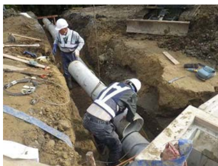
用排水管設置
