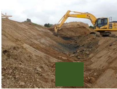
切土のり面仕上げ (土砂)
