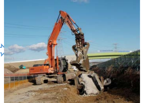
取壊し (圧碎機)
