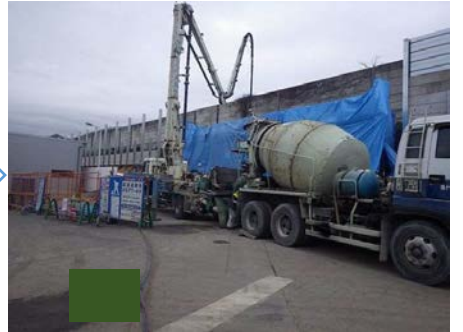
コンクリート打設・養生
