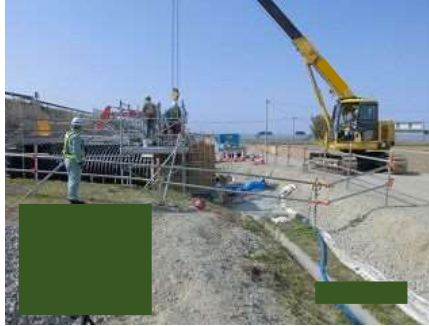
コンクリート打設①
