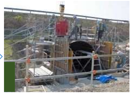
コンクリート打設②
