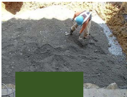
基礎材敷均し・締固め
