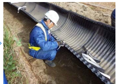
パイプ組立 (ボトムセクション)
