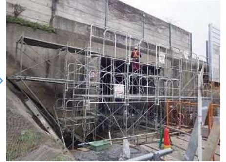
足場・支保設置
