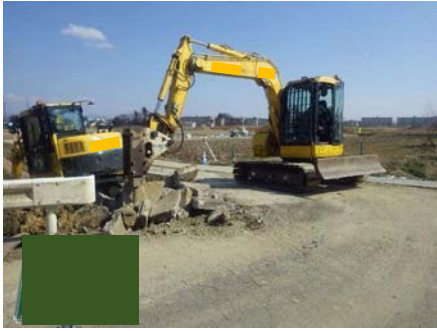
取壊し（大型ブレーカ）
