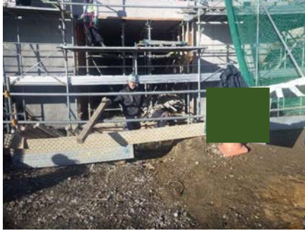
支保・型枠・足場撤去
