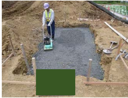
基礎材敷均し・締固め
