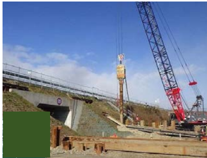
打込み (H型鋼)
