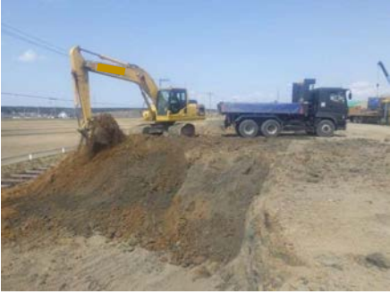
掘削・積み込み
