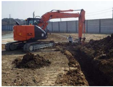
掘削・整正 (床付)
