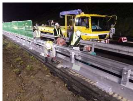
固定用アンカーピン打込み
