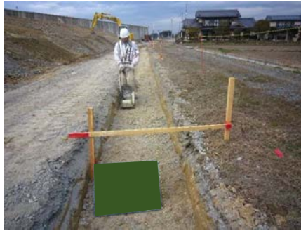
掘削・整正（床付）
