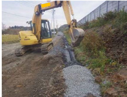
フィルター材設置
