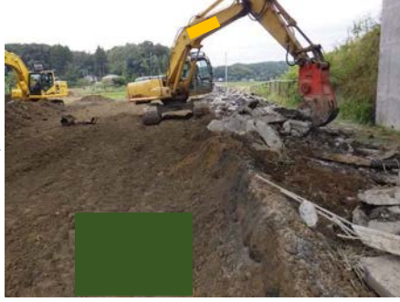
取壊し（圧碎機）
