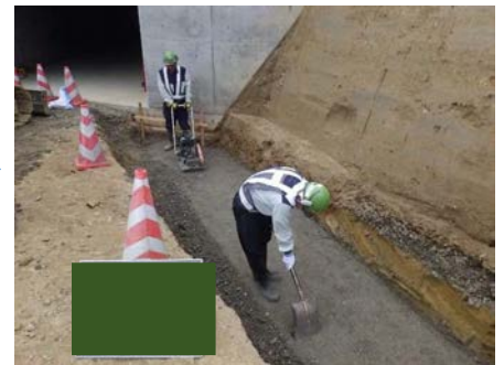
基礎材敷均し・締固め
