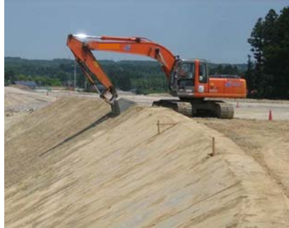
盛土のり面仕上げ (削取り)
