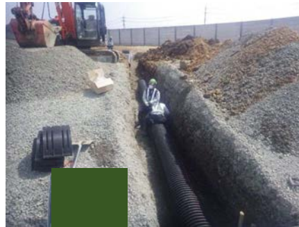
用排水管設置
