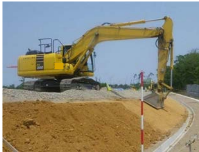
盛土のり面仕上げ (削取り)
