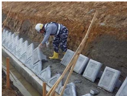
コンクリートブロック積み①
