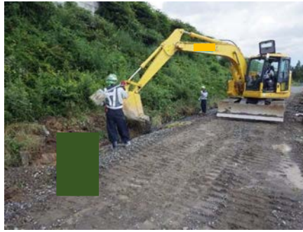
掘削・整正（床付）
