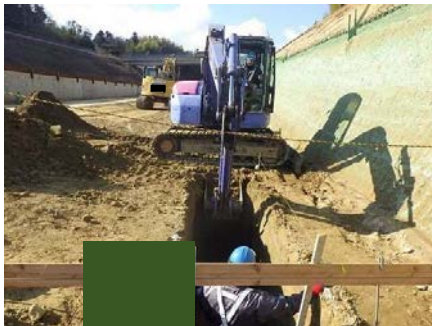
掘削・整正 (床付)
