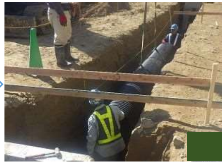
用排水管設置
