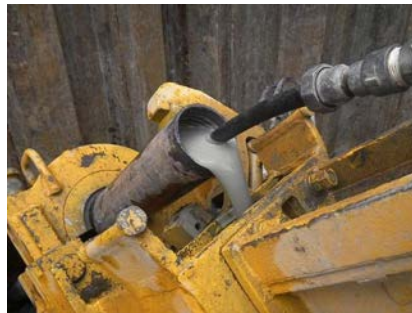
グラウト注入
