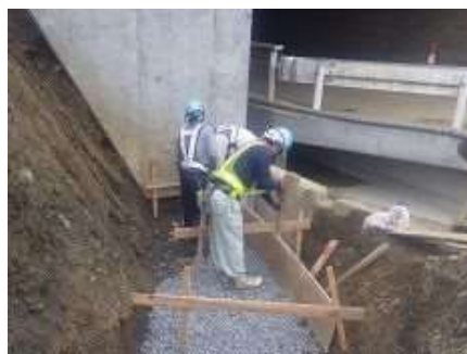
型枠製作・組立て
