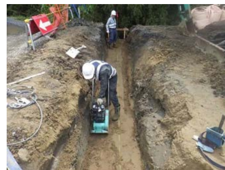
基礎材敷均し・締め
