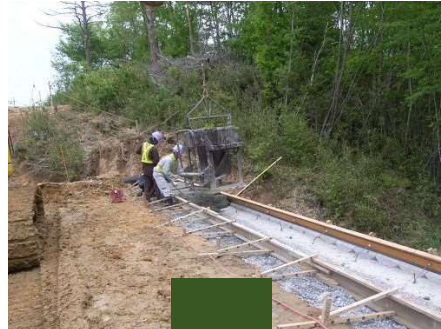
天端コンクリート打設
