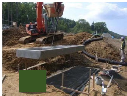
油水分離ます設置
