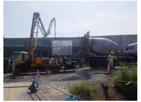
コンクリート打設・養生
