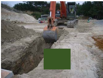
掘削・整正 (床付)
