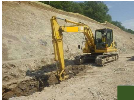
掘削・整正（床付）
