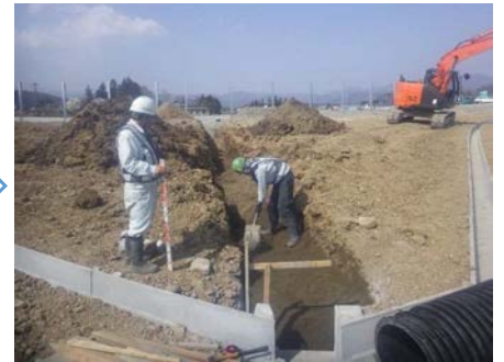
基礎材敷均し・締固め
