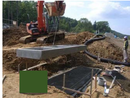
油水分離ます設置
