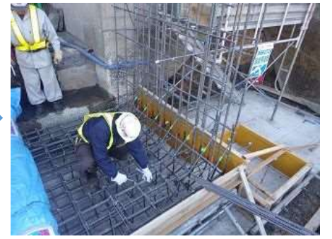
底版鉄筋加工・組立て
