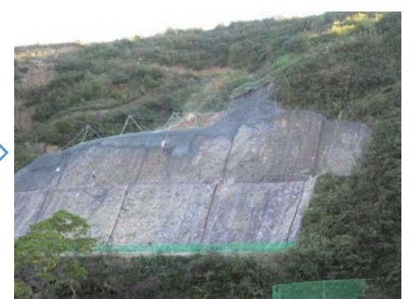
モルタル吹付
