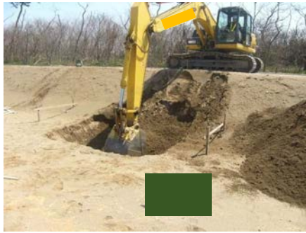
掘削・整正（床付）
