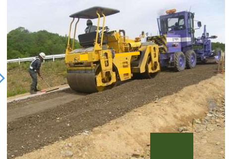
簡易舗装路盤工 (転圧)
