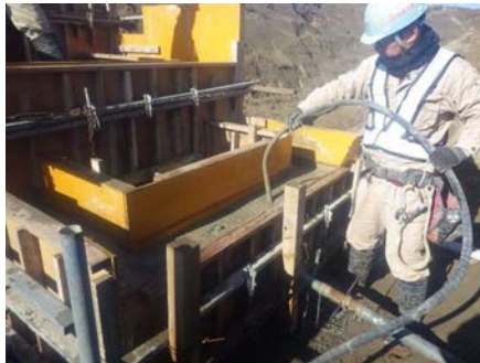
コンクリート打設
