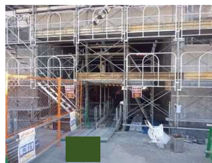
支保・型枠・足場撤去
