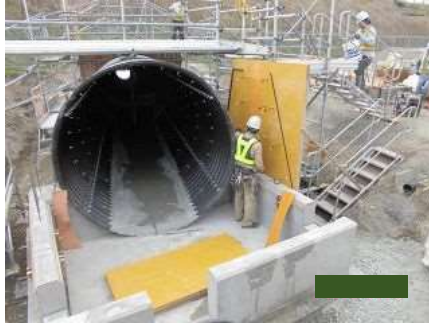
型枠組立①
