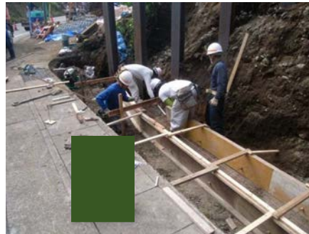
型枠製作・組立て
