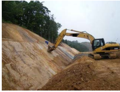
切土のり面仕上げ (土砂)
