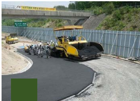
簡易舗装工 (敷均し)
