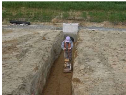
基礎材敷均し・締固め
