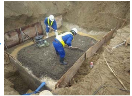
基礎材敷均し・締固め
