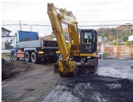
舗装版取壊し
