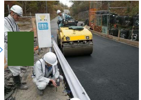
簡易舗装工 (締め)
