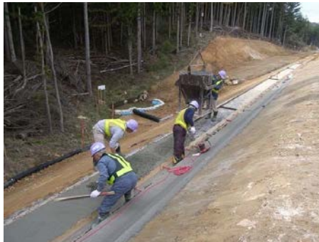
コンクリート打設
