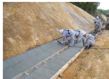
コンクリート打設
