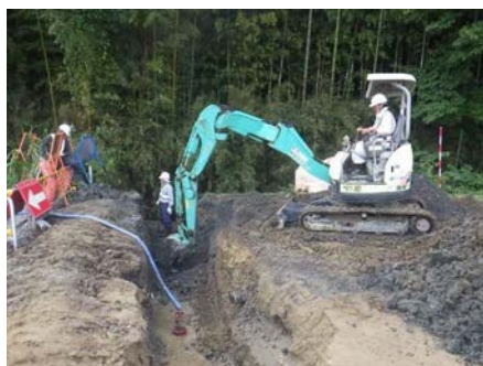
掘削・整正 (床付)
