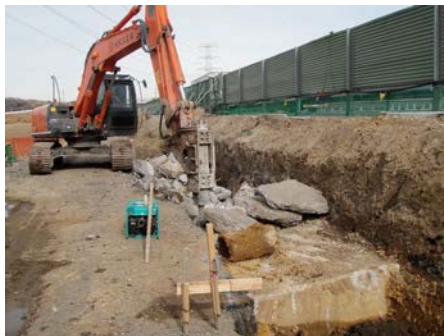
取壊し (大型ブレーカ)
