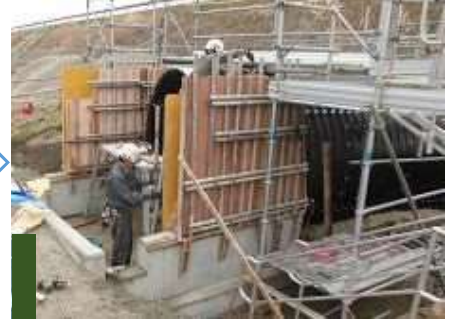
型枠組立②
