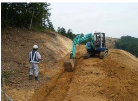
掘削・整正 (床付)
