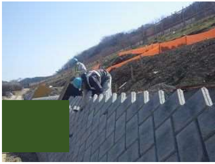
コンクリートブロック積み②
