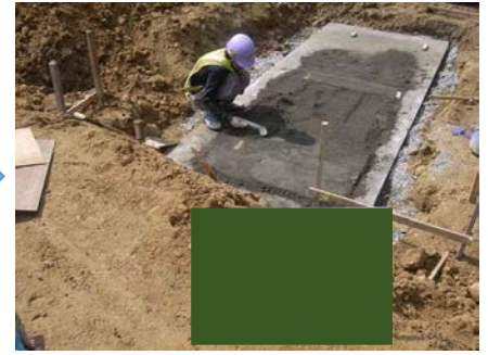
敷モルタル設置
