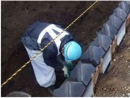
コンクリートブロック積み①
