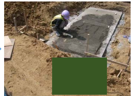
敷モルタル設置
