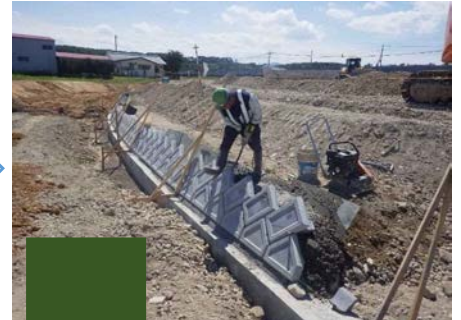
胴込め (コンクリート)
