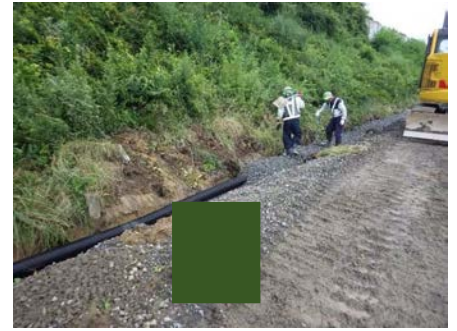
地下排水管設置
