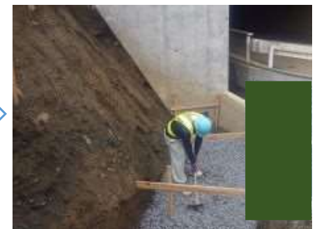
基礎材敷均し・締固め
