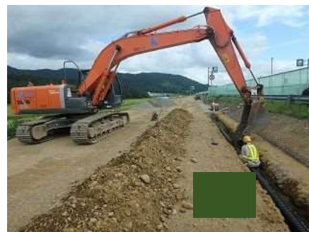
フィルター材設置
