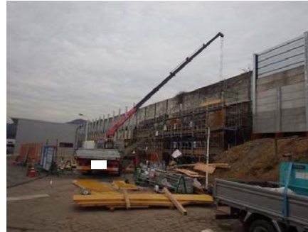
型枠製作・組立て
