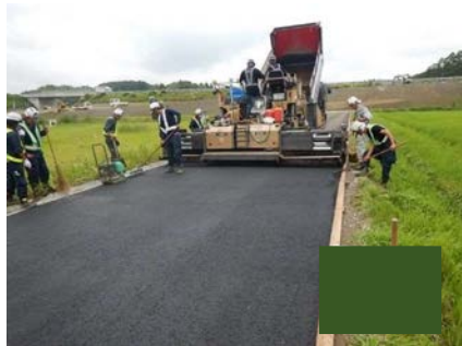
簡易舗装工（敷均し）
