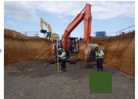
基礎材敷均し
