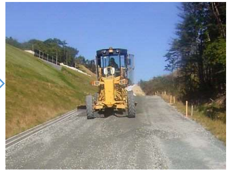
簡易舗装路盤工
