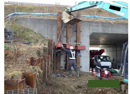
鋼製山留材設置
