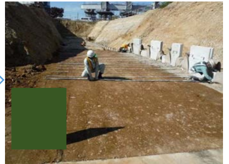
補強材設置
