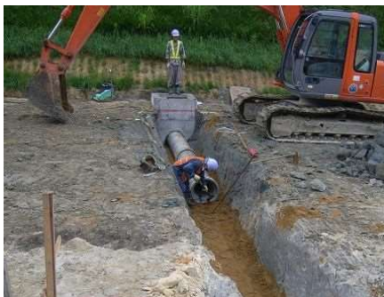
用排水管設置
