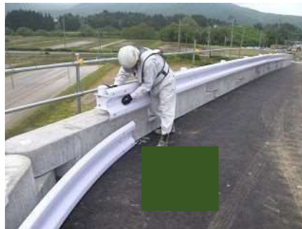
レール等設置
