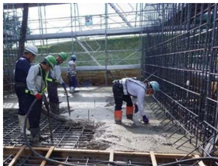
底板コンクリート打設
