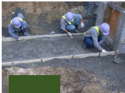
均しコンクリート打設
