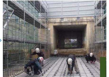
底板鉄筋加工・組立て
