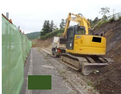
掘削・積込み
