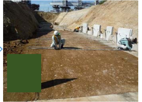
補強材設置
