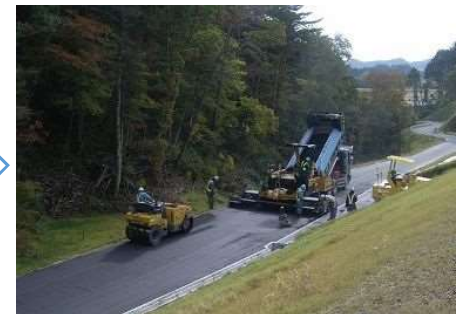
簡易舗装工（締固め）
