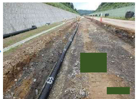
地下排水管設置
