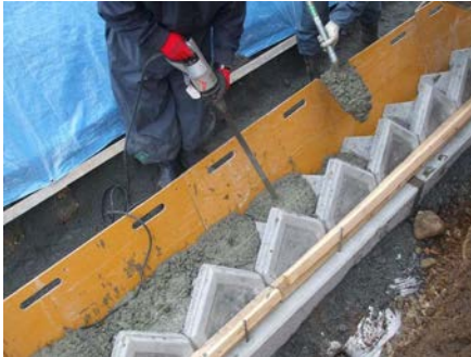
胴込め（※コンクリート打設の場合）
