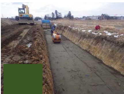
基礎材敷均し・締固め
