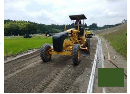
簡易舗装路盤工
