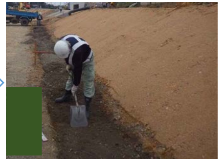
基礎材敷均し・締固め
