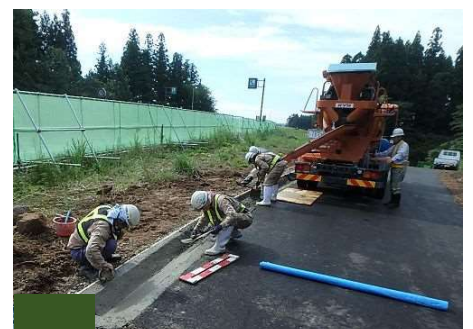
コンクリート打設
