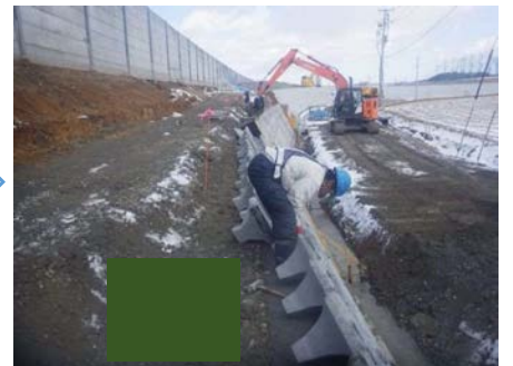
コンクリートブロック積み②
