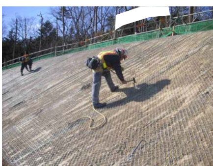
アンカーピン設置
