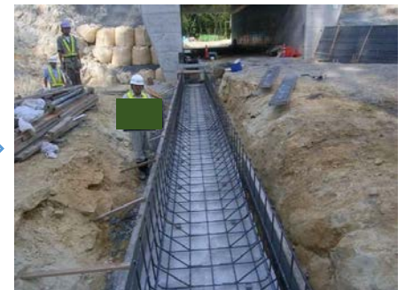
鉄筋加工・組立て
