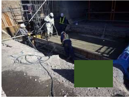
↓ 底版コンクリート打設
