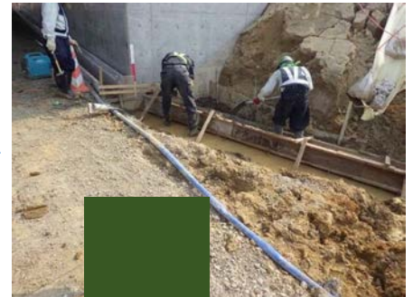
コンクリート打設
