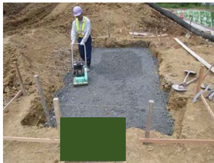
基礎材敷均し・締固め
