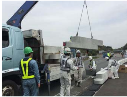
連続基礎ブロック設置
