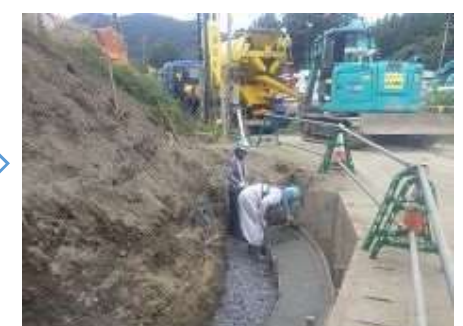
コンクリート打設
