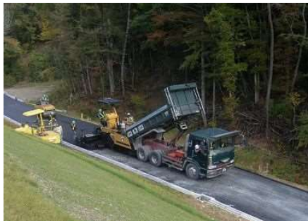
簡易舗装工（敷均し）
