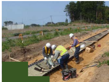
パイプ組立 (ボトムセクション)
