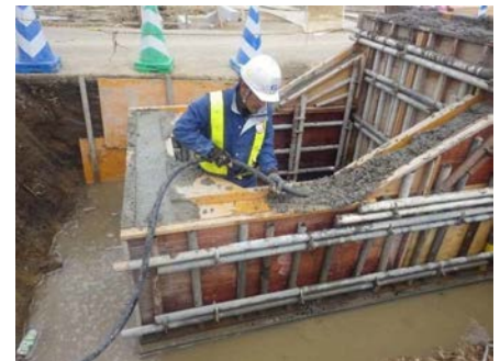
コンクリート打設
