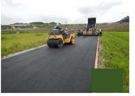
簡易舗装工（締固め）
