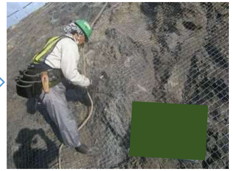
アンカーピン設置
