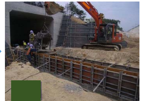
コンクリート打設
