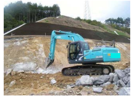
切土のり面仕上げ (硬岩)
