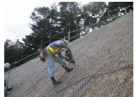
アンカーピン設置
