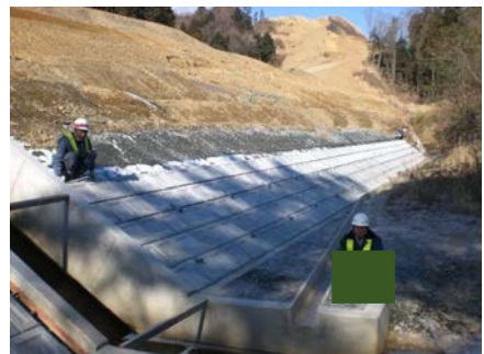
コンクリートブロック張り
