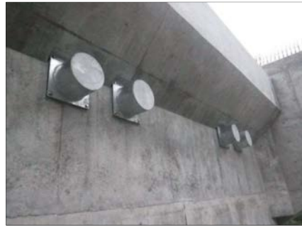
落橋防止構造 橋台側
