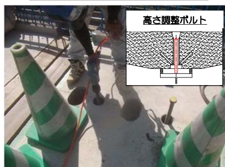
調整工（高さ調整ボルトによる）
