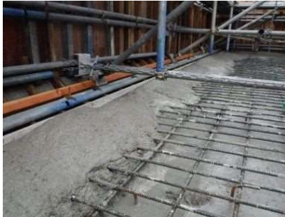
ウエブ下ハンチ部コンクリート充填
