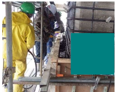
コンクリート打設
