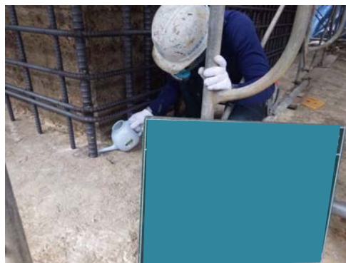
アンカー鉄筋樹脂定着
