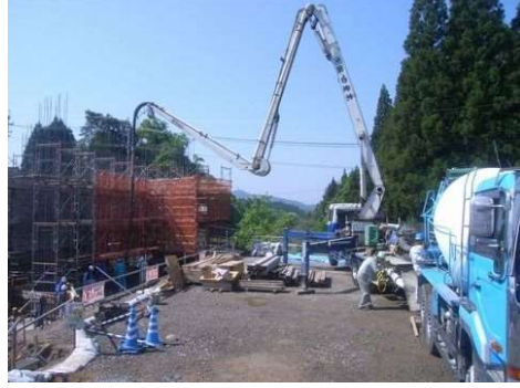
コンクリート工
