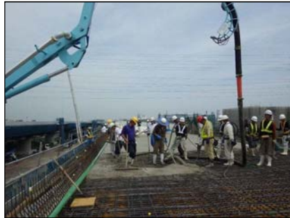
コンクリート打設
