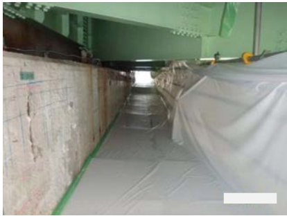
足場設置（内観）
