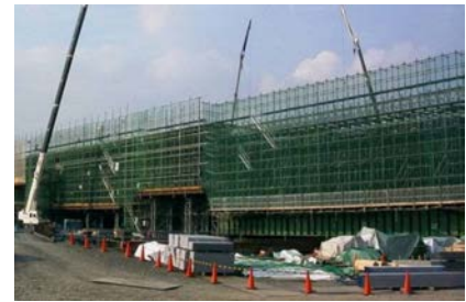
梁(架設桁)+くさび結合式支保工
