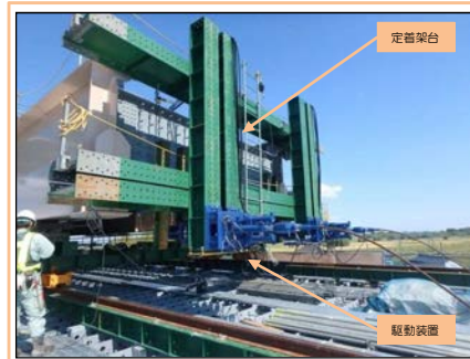
駆動装置・定着装置
