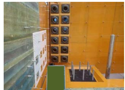
緊張端付近の型枠状況
