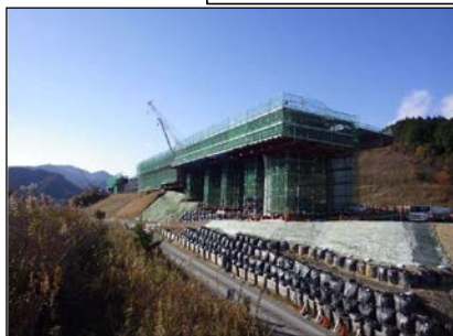
支柱式支保工施工例（H鋼梁）
