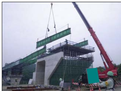
手延機・連結構解体
