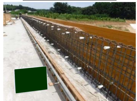
コンクリート打設(壁高欄)
