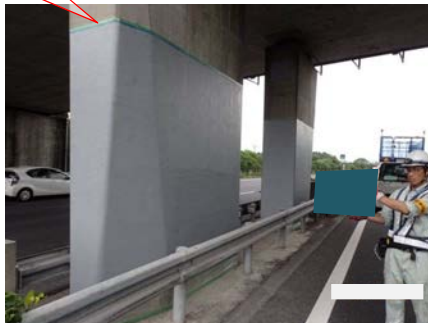
不陸修正完了
