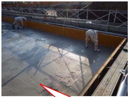
棒状振動機による締固め
