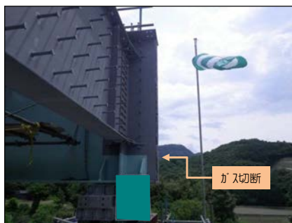
桁端処理
