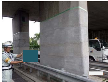
保護塗装（下塗り）完了
