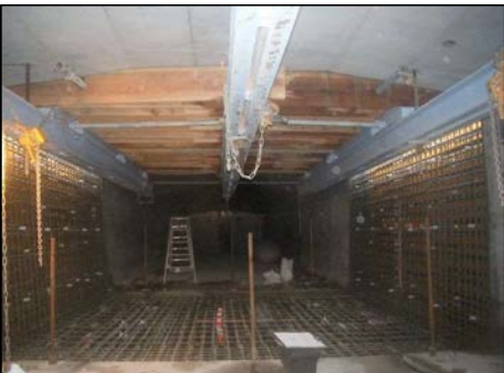
コンクリート打設
