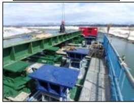
送出し装置 (ジャッキ式)
