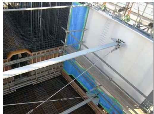
波形鋼板養生
