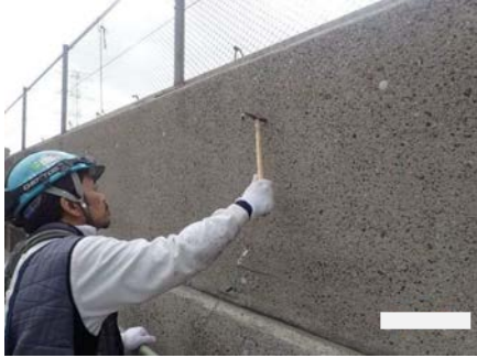
目視、打音検査
