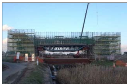
トラス梁特殊支保工+くさび結合式支保工
