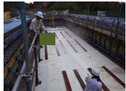
内型枠脱枠
