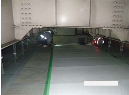
シート張り防護
