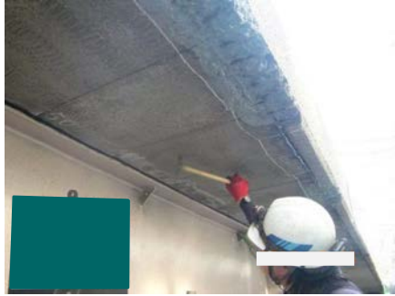
変状部分の確認・除去
