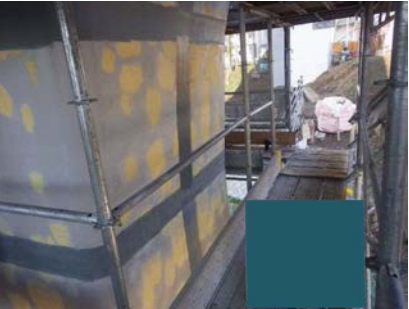
溶接部 下塗り完了
