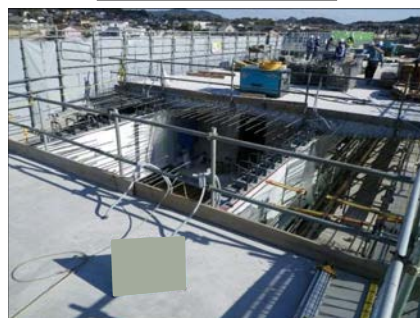
波形鋼板架設
