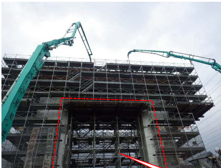
横梁部足場・支保工
