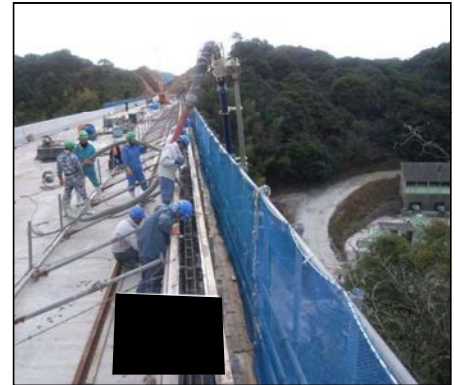
壁高欄の施工
