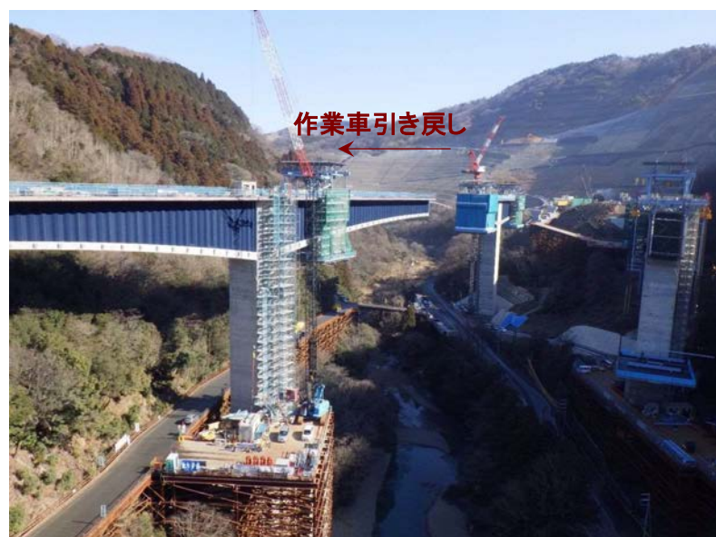
作業車を橋脚付近まで引き戻した後、作業台を桁下に吊り降ろし、クレーンを使用して解体する
