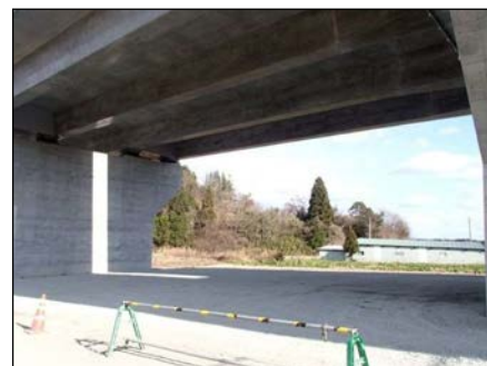
型枠支保工撤去完了
