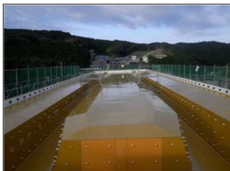
型枠組立完了
