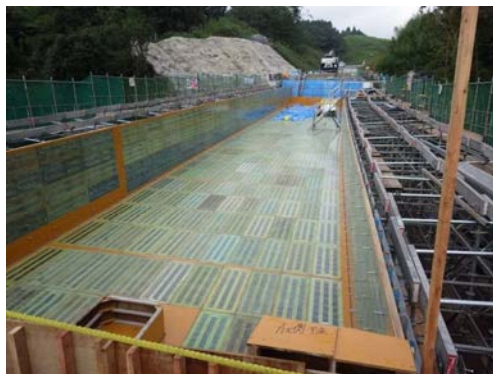
底板・側型枠組立
