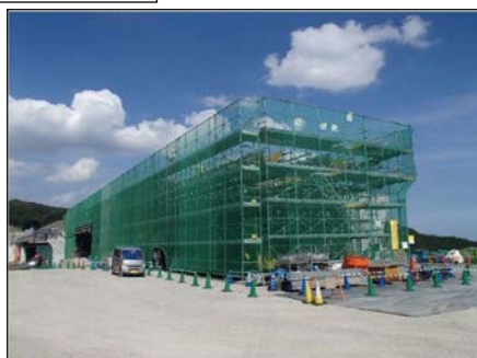
くさび結合式支保工施工例
