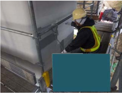
下塗り塗布状況
