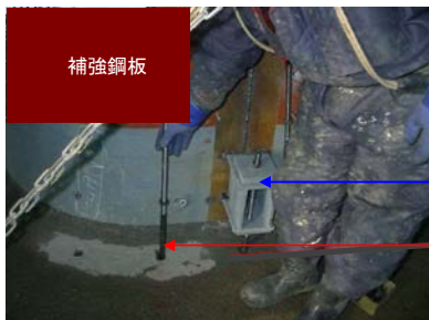
アンカーボルト取付状況
