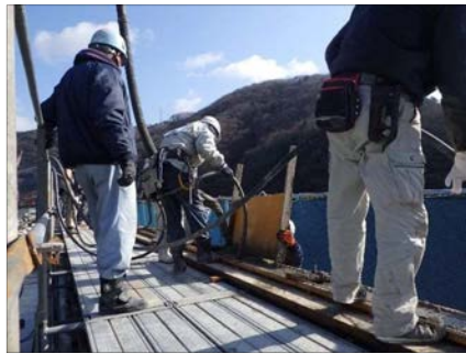
コンクリート打設
