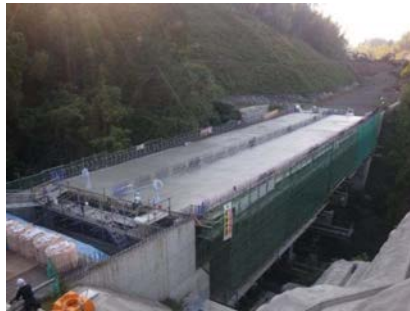
コンクリート打設完了
