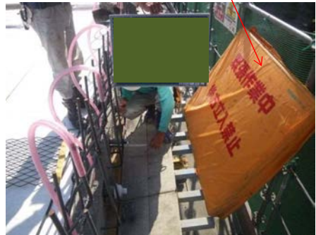
緊張状況（固定側）
