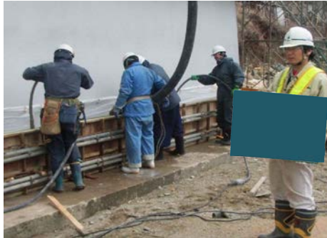
コンクリート打設状況
