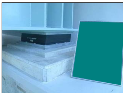
モルタル打設完了
