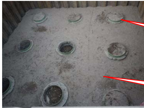
鋼管ソイルセメント杭 (杭頭処理前)
