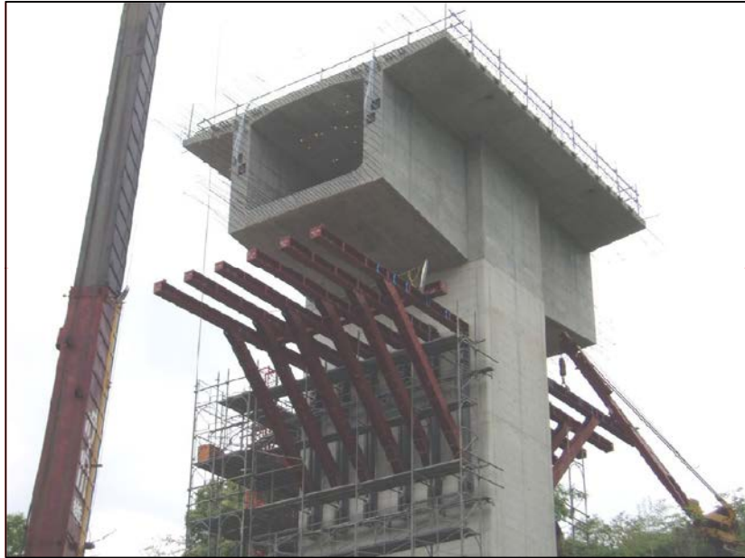
ブラケットを解体して、柱頭部工完了
