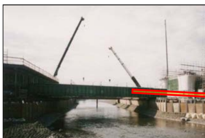
梁(架設桁)架設状況
