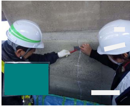
②ひび割れ幅の確認
