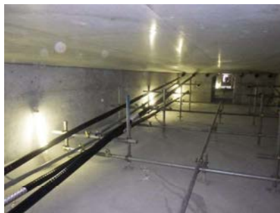
外ケーブル組立状況
