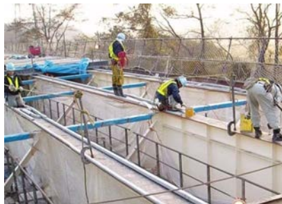
フランジシール工
