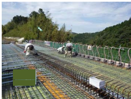
鉄筋・横締め設置状況
