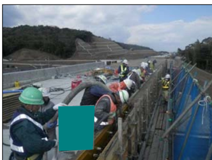
コンクリート打設
