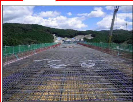
鉄 筋 組 立 完 了
