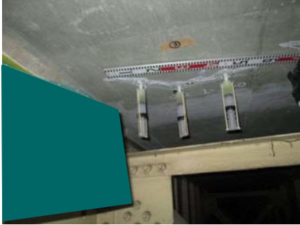
ひび割れ注入
