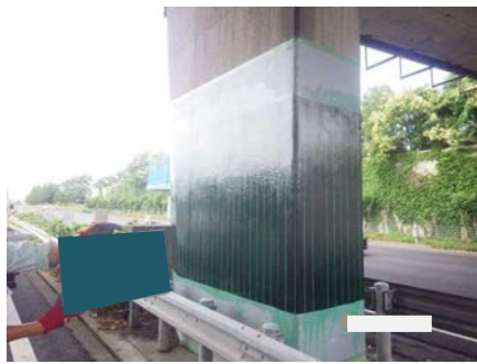
含浸接着樹脂塗布完了
