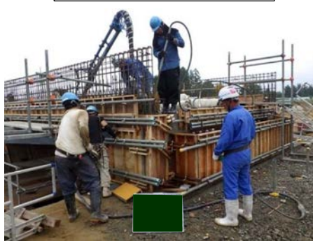
コンクリート打設
