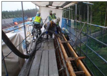
壁高欄コンクリート打設
