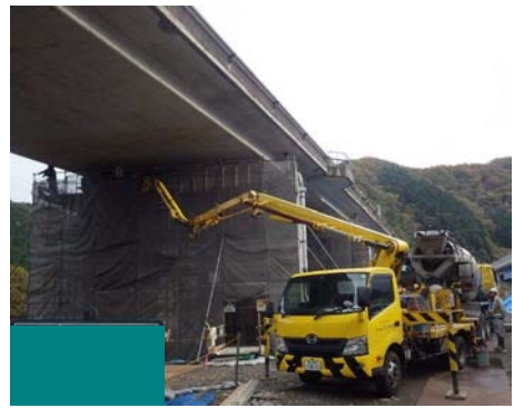
コンクリート打設
