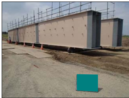
地組立(ボルト接合)
