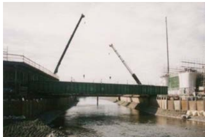
梁(架設桁)架設状況
