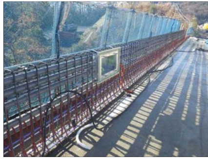
落橋防止構造 橋台側
