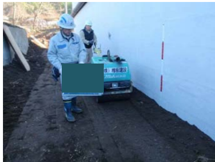
構造物掘削（掘削後転圧）
