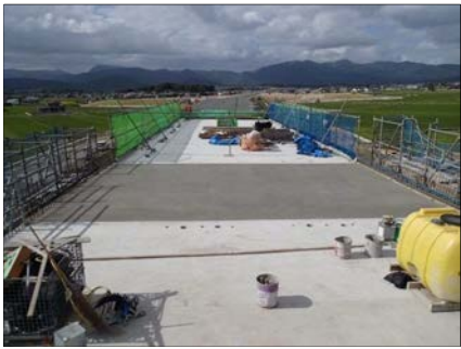
上床版コンクリート打設
