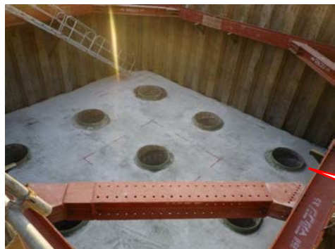
鋼管ソイルセメント杭 (杭頭処理後)
