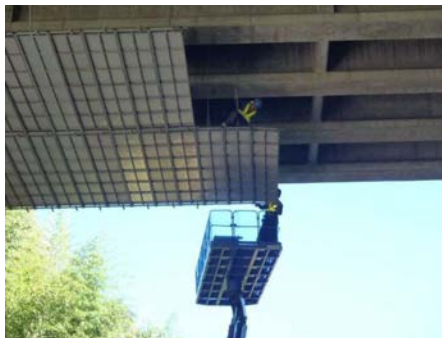
システム足場組立
