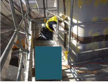
溶接部ケレン状況
