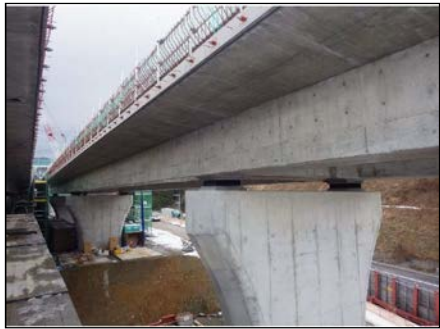
支保工撤去完了(参考例)
