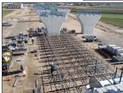
くさび結合式支保工施工例
