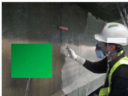
①プライマー塗布
