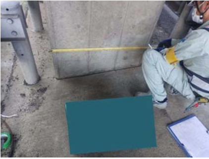
躯体寸法確認
