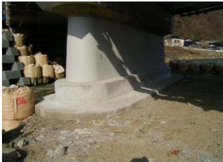
コンクリート打設完了
