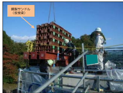
降下設備組立
