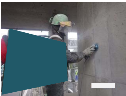
コンクリート表面処理 ケレン状況
