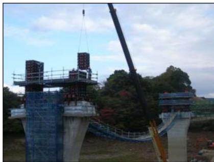
降下設備組立
