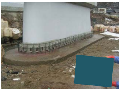
鉄筋組立完了
