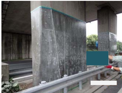
プライマー塗布完了
