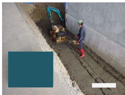
埋戻し・締固め
