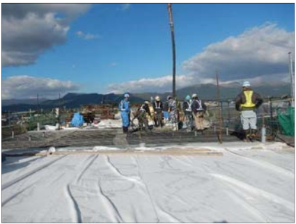
上床版コンクリート打設
