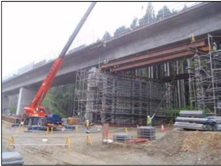
支保工撤去状況(参考例)
