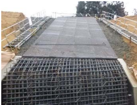
コンクリート打設
