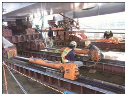
送出し装置用逸走防止装置
