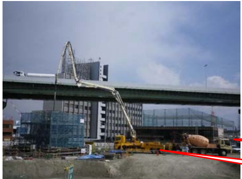
コ ン ク リ ー ト 工
