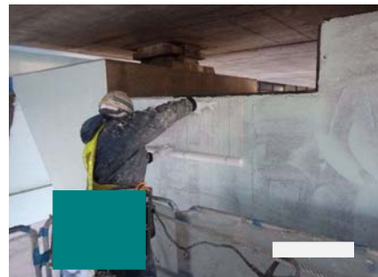
④連続繊維シート接着
