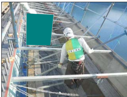
張出部支保工
