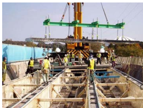
調整工（高さ調整ボルトによる）
