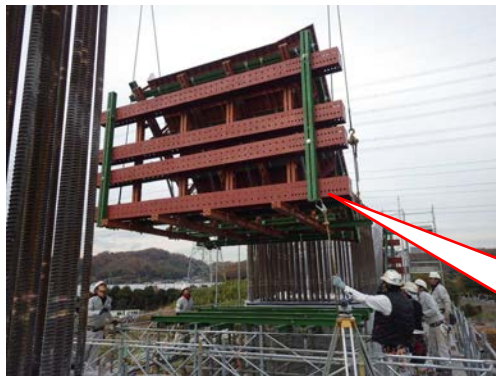
型枠工（底枠）
