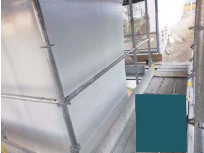
下塗り塗布完了
