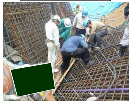
コンクリート打設
