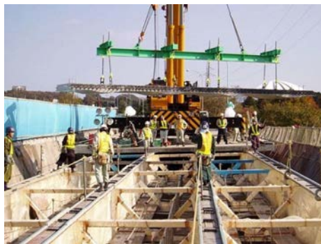
調整工 (高さ調整ボルトによる)
