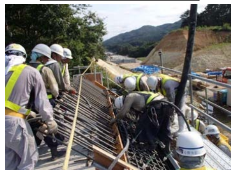
コンクリート打設
