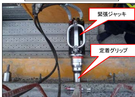
横 締 め 緊 張 状 況
