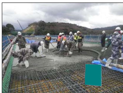
コンクリート打設
