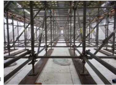
床版型枠設置完了
