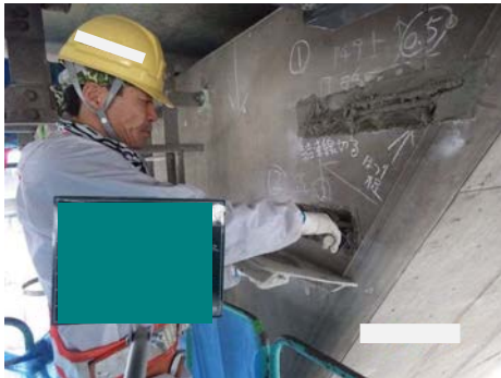
断面修復材塗布
