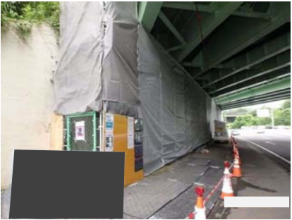
足場設置（外観）
