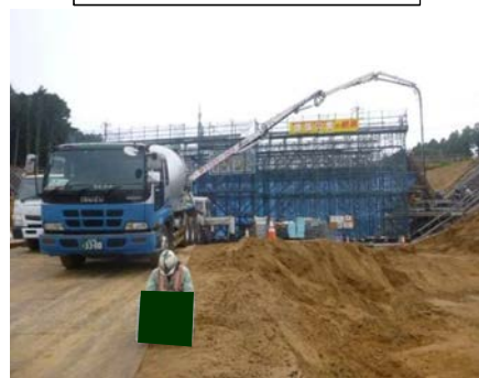
コンクリート打設
