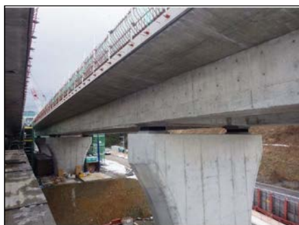
型枠支保工撤去完了
