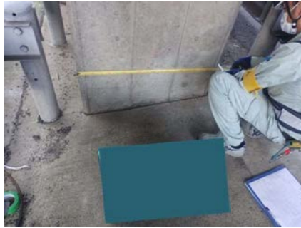
躯体寸法確認
