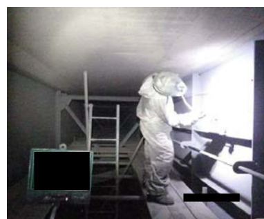
塗膜剥離剤塗布
