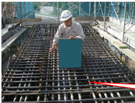
支承アンカー用の箱抜きを設置するために、鉄筋をずらして配置する。
