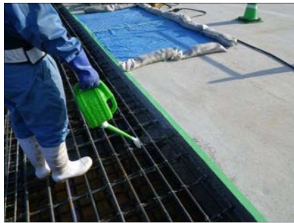
上床版コンクリート打設
