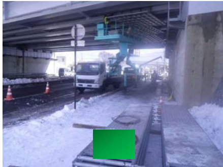
システム足場撤去
