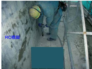
取付アンカー削孔状況
