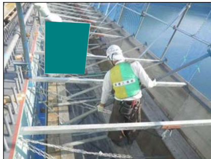
張 出 部 支 保 工
