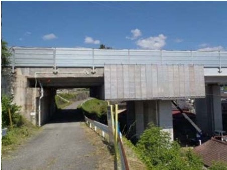
システム足場組立
