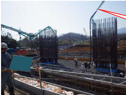
コ ン ク リ ー ト 工
