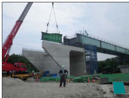
手延機・連結構解体
