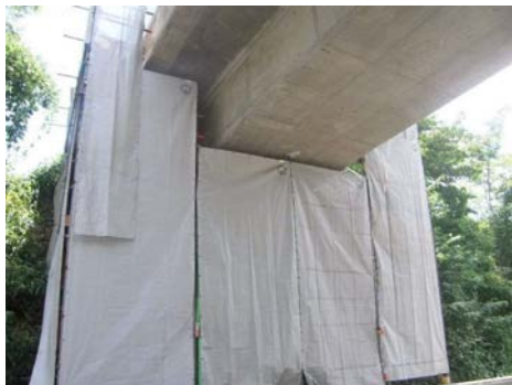
シート防護設置
