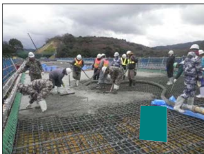
コンクリート打設
