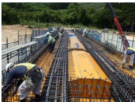
鉄筋組立作業状況
