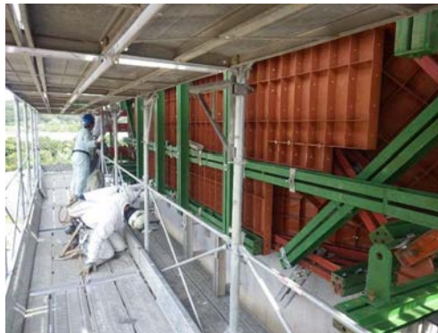
型 枠 工 ( 側 枠 )
