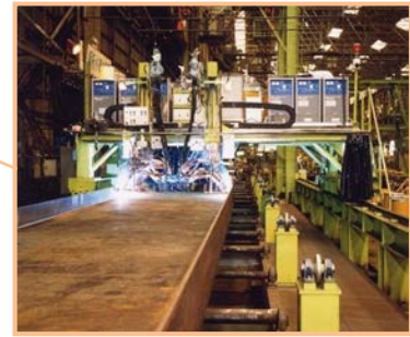
※腹板・フランジの溶接
