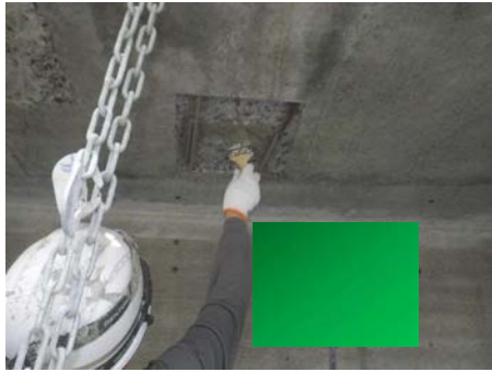
鉄筋防錆処理
