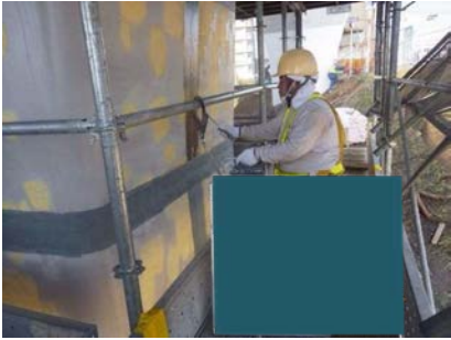
溶接部 下塗り状況
