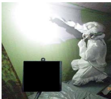
塗膜剥離剤塗布
