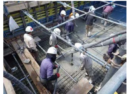
下床版コンクリート打設
