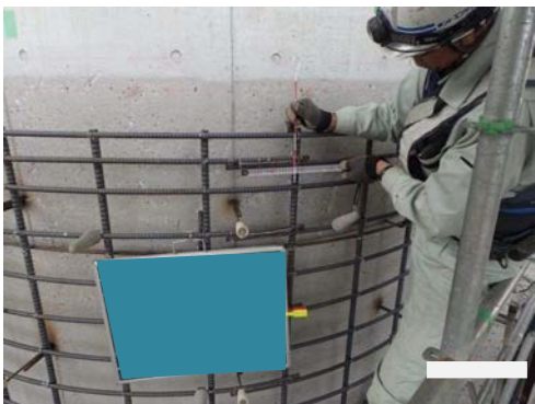
フレア溶接 外観形状寸法確認
