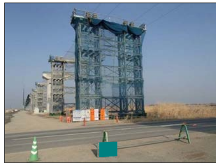
ペント設備組立完了
