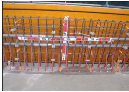
壁高欄コンクリート打設
