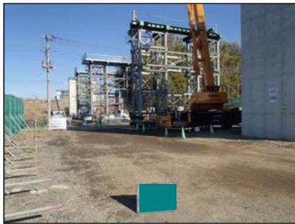
ペント設備組立
