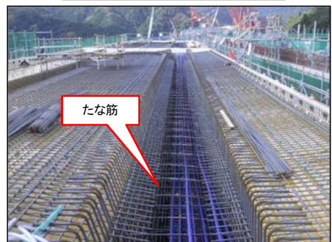
縦 締 め ケ ー ブ ル 配 置 完 了
