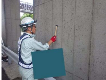
目視、打音検査
