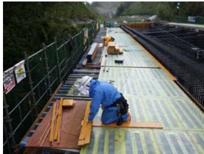
張出床版型枠設置
