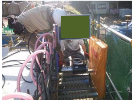
緊張状況（緊張側）
