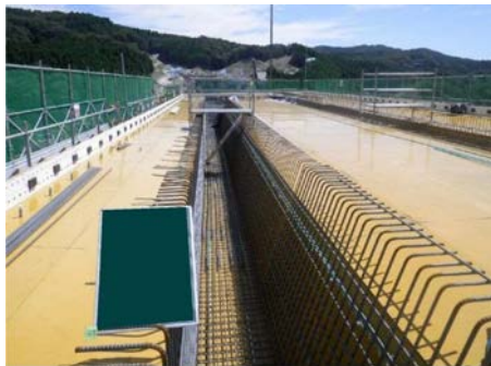
鉄筋組立作業状況
