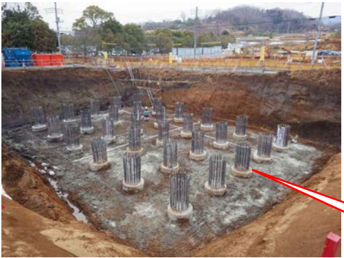
場所打ち杭 (杭頭処理後)
