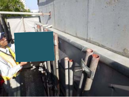
モルタル打設完了
