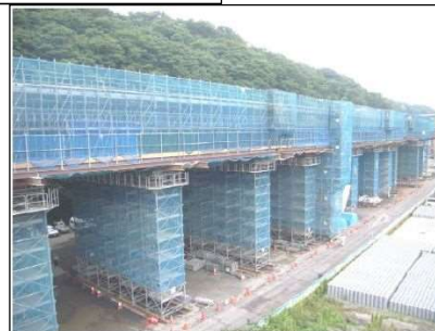
支柱式支保工施工例（H鋼梁）
