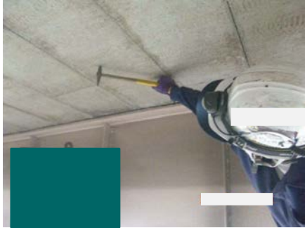
変状部分の確認・除去
