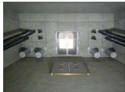
落橋防止構造 桁側
