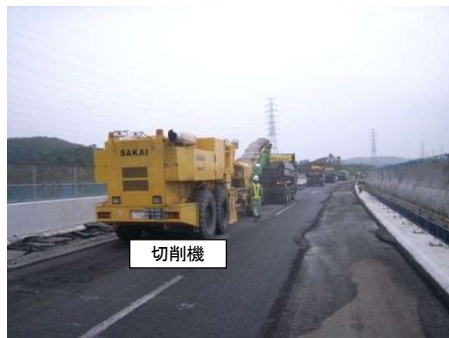
橋面舗装撤去
