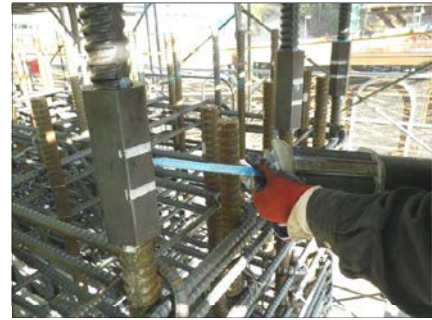
鉄筋継ぎ手
