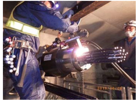
外ケーブル施工完了
