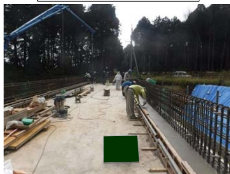
コンクリート打設(地覆)
