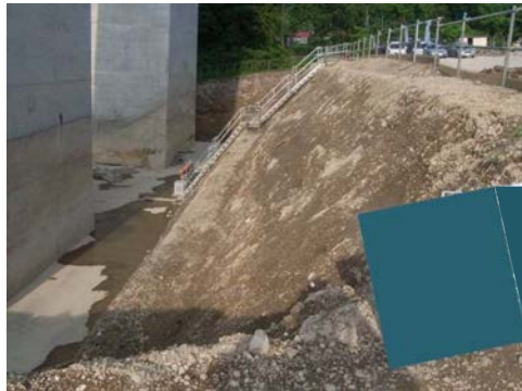
構造物掘削完了
