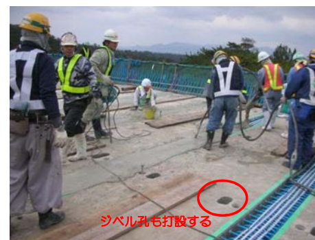
接合部コンクリート打設
