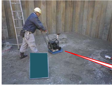
基礎砕石 敷き均し・締固め
