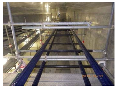
外ケーブル施工完了
