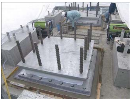
無収縮モルタル打設
