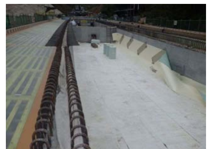
内型枠脱枠
