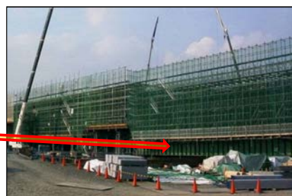
梁(架設桁)+くさび結合式支保工
