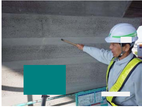
目視、打音検査
