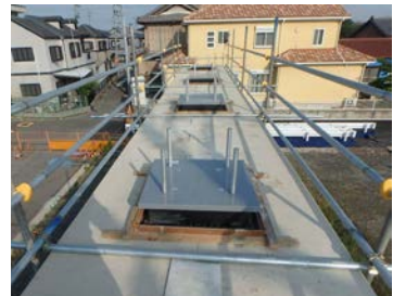
ゴム支保据付状況
