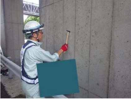
目視、打音検査
