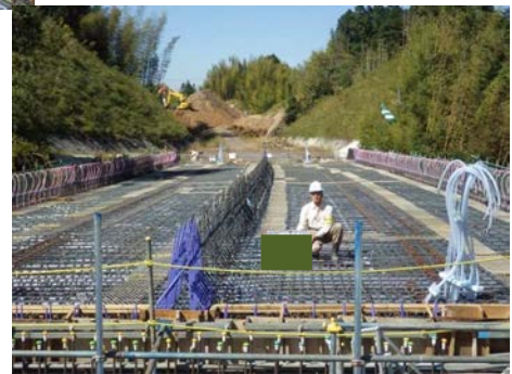
上床版打設前状況全景
