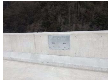
落橋防止構造 桁側
