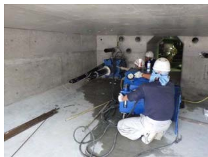
外ケーブル緊張状況
