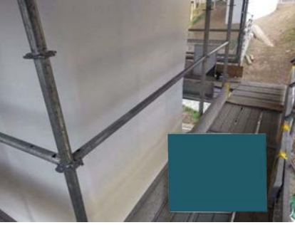
中塗り塗布完了
