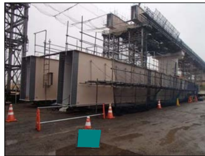
地組立(ボルト接合)
