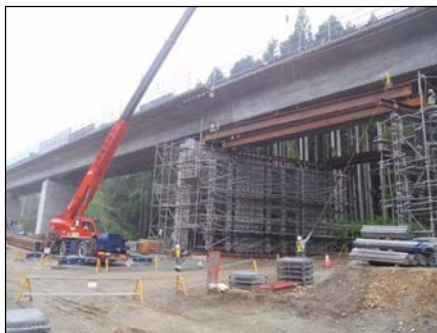
型枠支保工撤去完了
