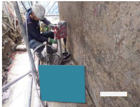
アンカー鉄筋樹脂定着
