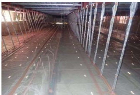
足場養生設備
