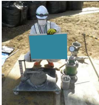
コンクリート受入検査
