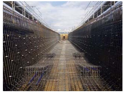
鉄筋・縦締め組立完了
