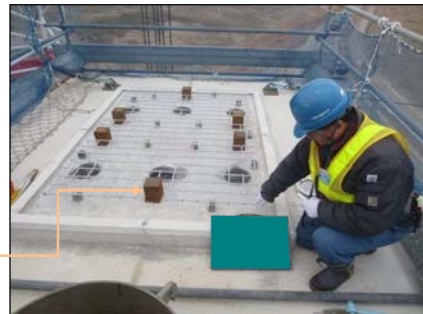
沓座鉄筋設置
