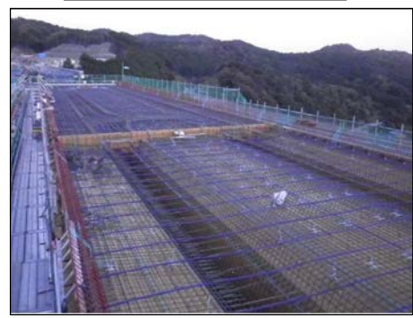
床 版 横 締 め ケ ー ブ ル 配 置 完 了
