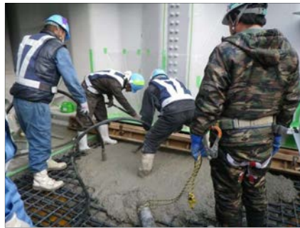
下床版コンクリート打設
