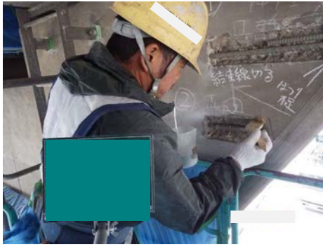
プライマー塗布
