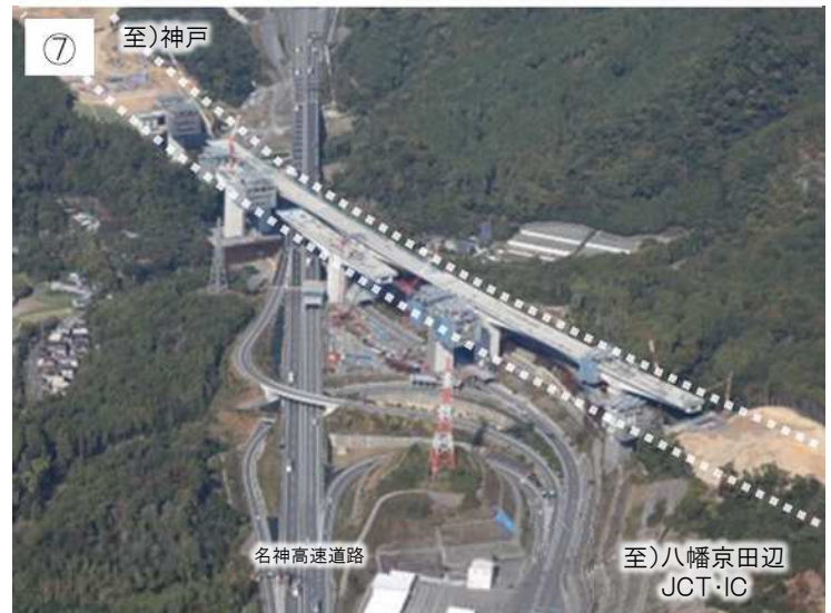
高槻JCT・IC付近の整備状況
