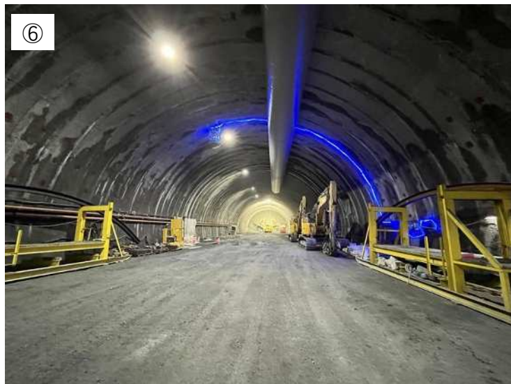
梶原トンネルの工事状況
