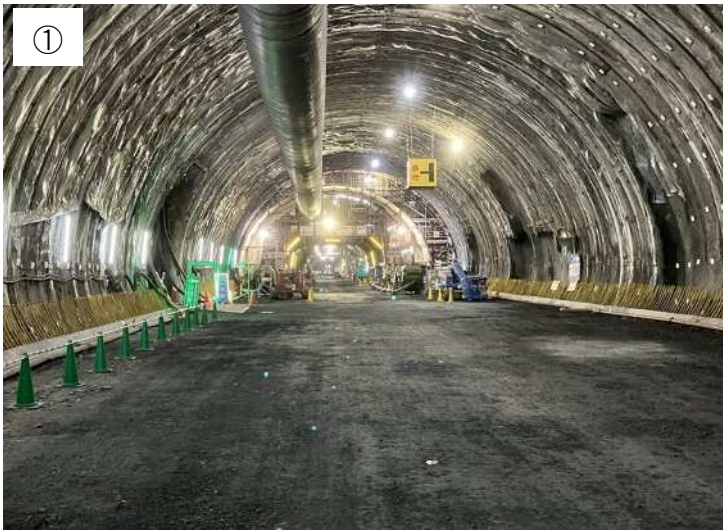
宇治田原トンネルの整備状況
