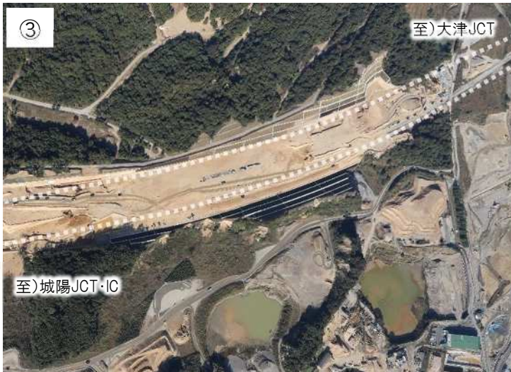
城陽市域土工部の整備状況
