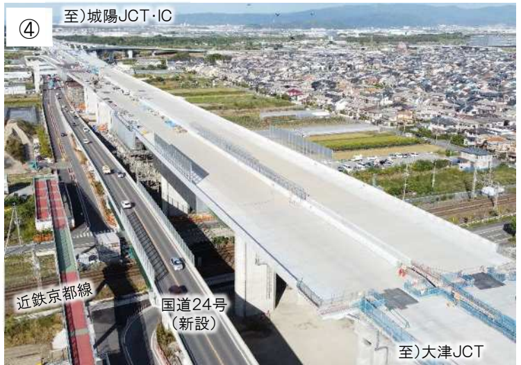
城陽高架橋の整備状況
