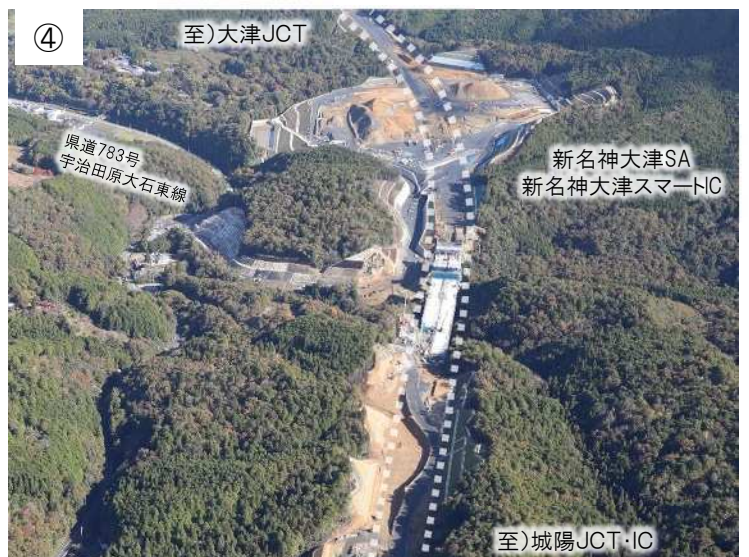
山間部(大石地区)の整備状況
