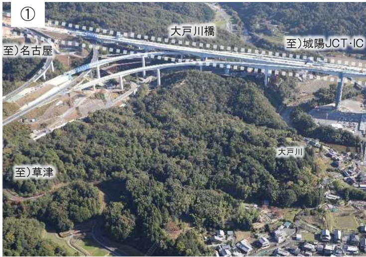
大戸川橋の整備状況
