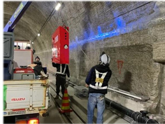
[消火栓 施工中]
