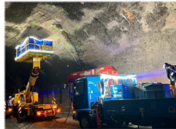
[注入孔削孔状況]
