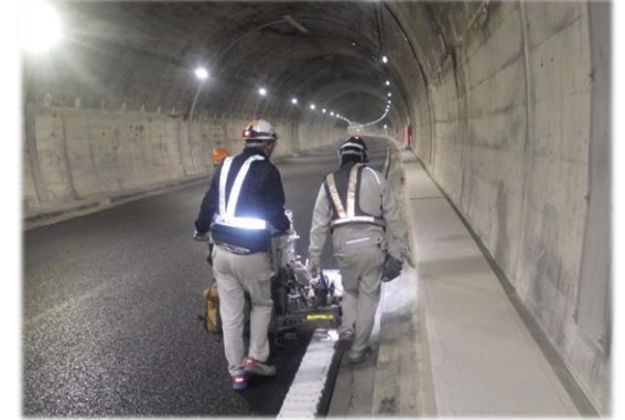
[路面標示施工状況]
