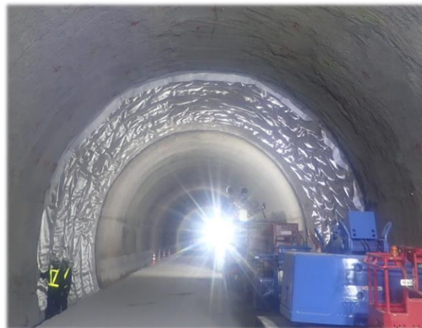
[防水シート設置状況]
