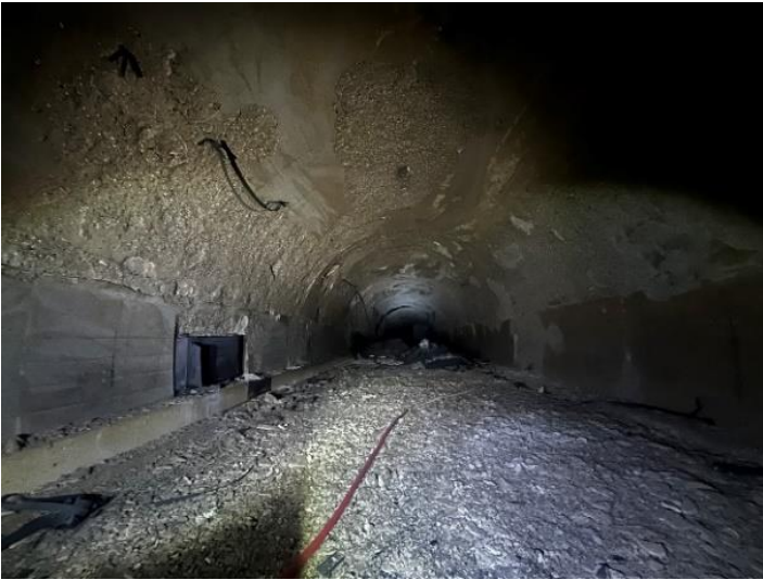
トンネル内部(全景)
