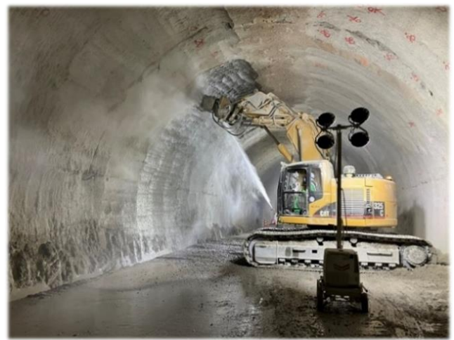
[覆工切削作業状況]
