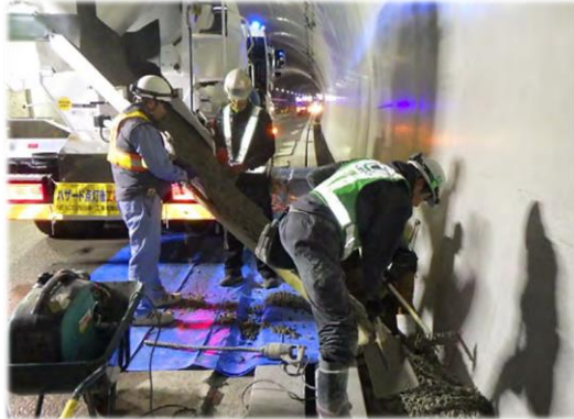
[監査廊復旧状況]
