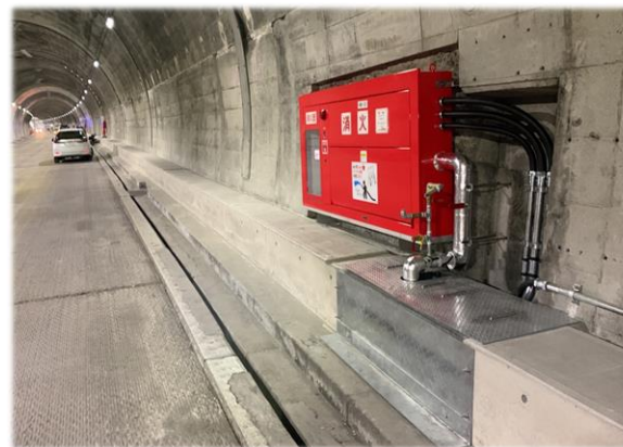
[消火栓 施工後]
