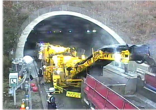
[路面切削（剥ぎ取り）状況]
