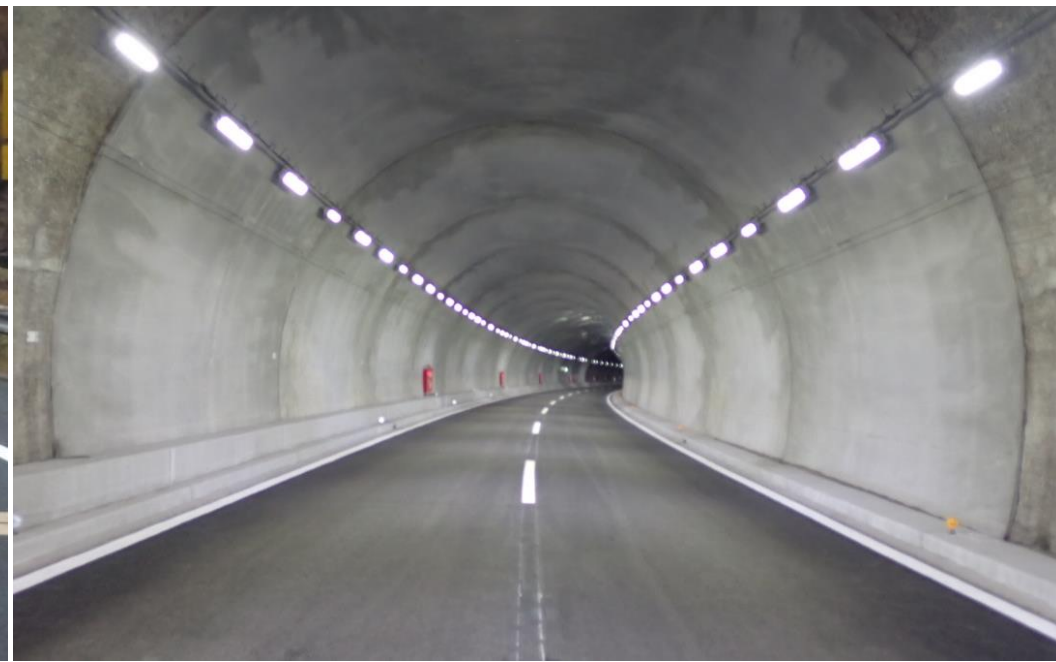
[下り線トンネル坑内]
