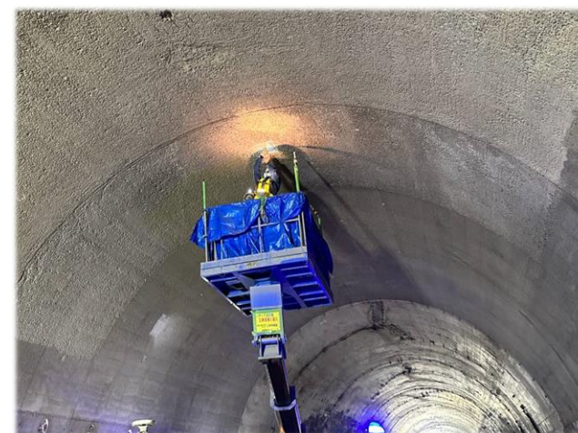
[はく落防止剤塗布作業状況]
