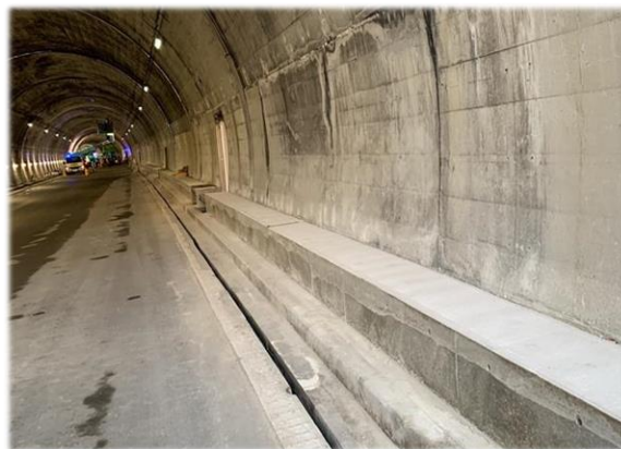
[配水本管 施工後]
