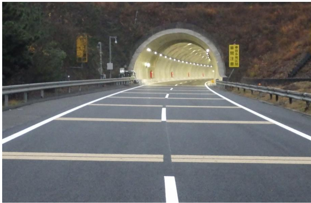
[下り線東坑口]
