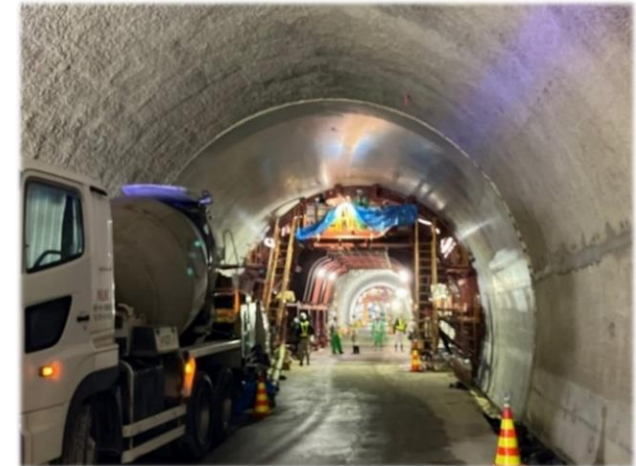
[コンクリート打設状況]
