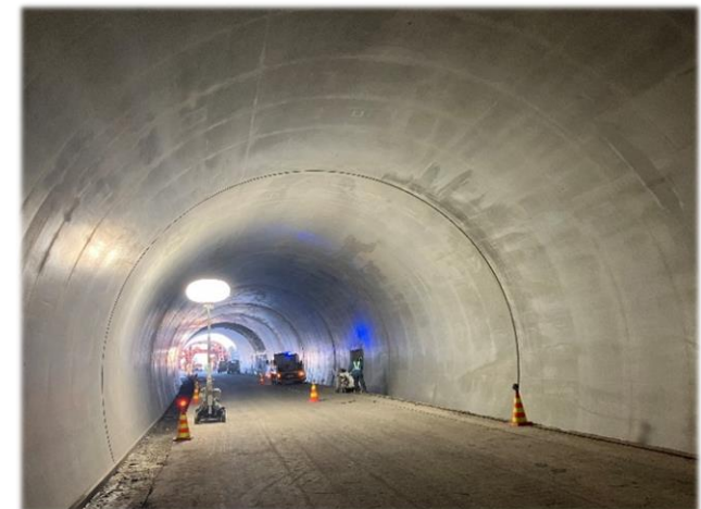
[コンクリート打設後]
