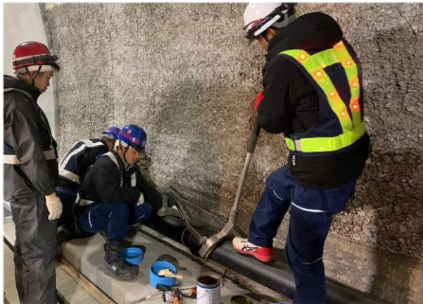
[配水本管 施工中]
