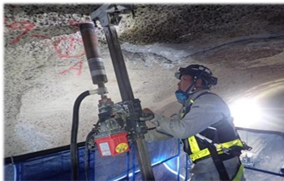
[ボーリングコア削孔状況]
