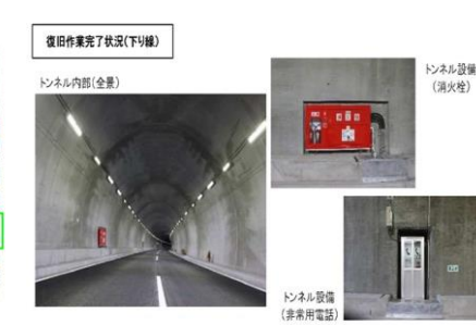
復旧作業完了状況
