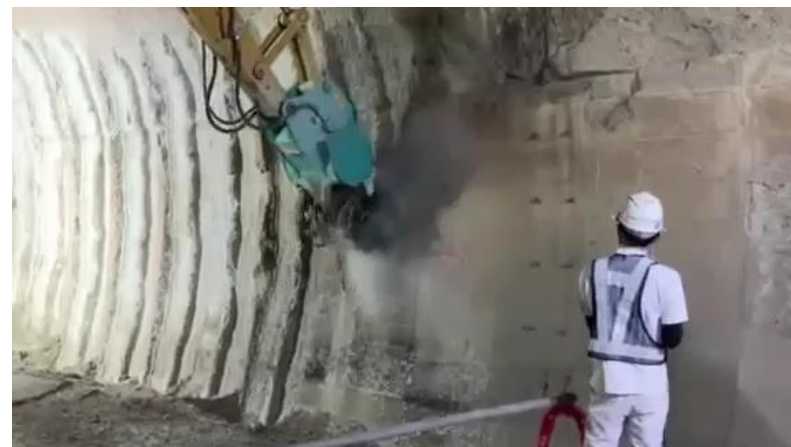
[覆工切削作業状況 (動画)]
