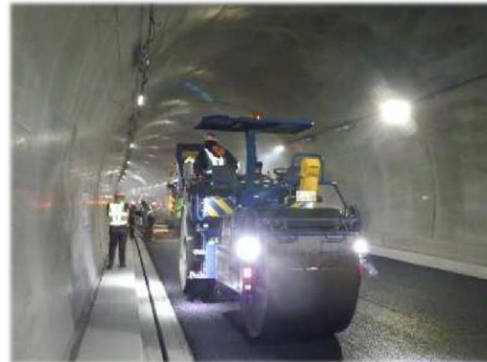
[舗装転圧状況]
