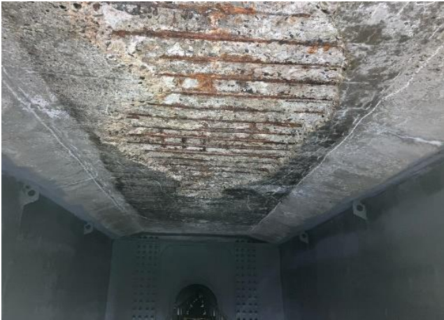
床版取替前(コンクリート床版下面)
