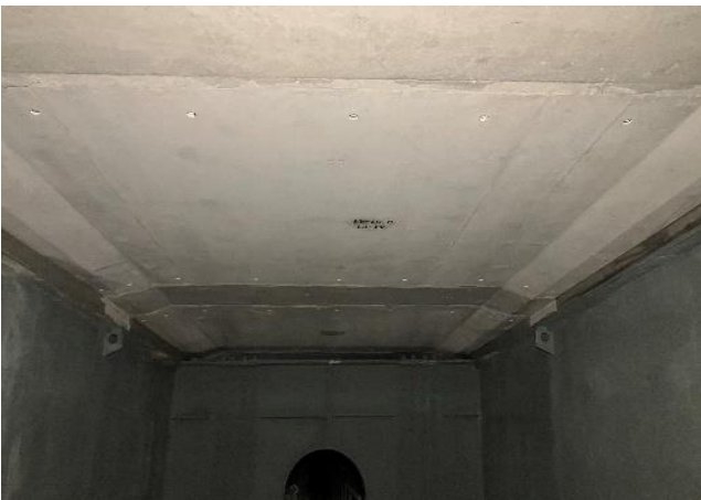
床版取替後(プレキャストPC 床版下面)
