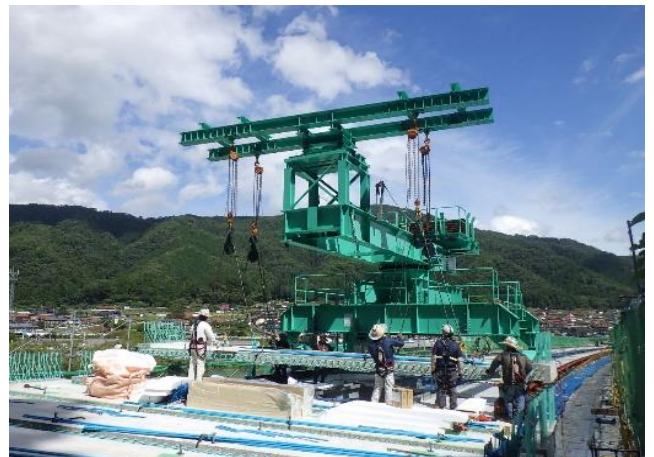
床版取替状況
