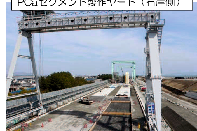
PCaセグメント製作ヤード（右岸側）
