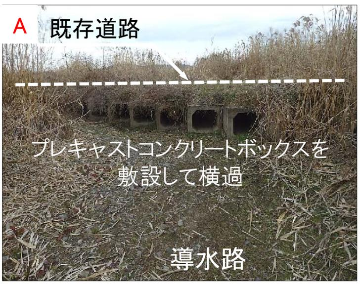
② 導水路横断箇所 工事用道路縦断図
