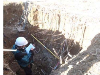
地下部掘削調査
