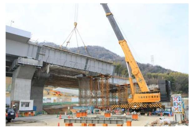
※架設時に橋桁を仮に支える支柱
