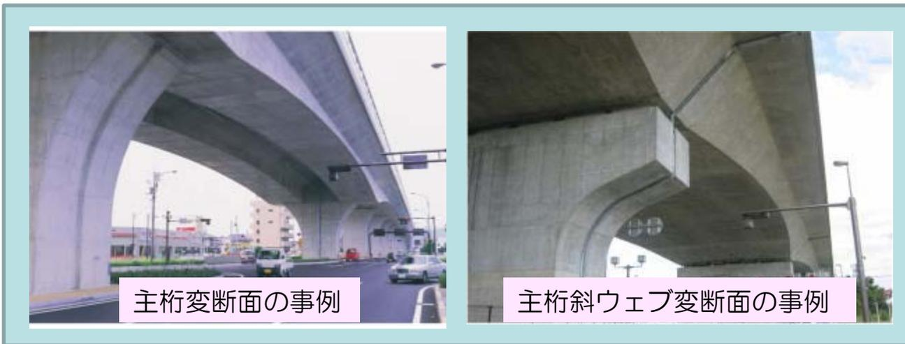
主桁変断面の事例
