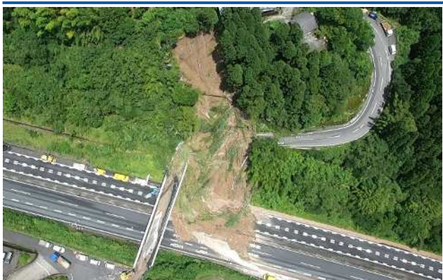
九州自動車道 溝辺鹿兒島空港IC～加治木JCT (のり面土砂崩れ／高速道路の災害対応)
