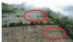
1 切土のり面上部の変状
