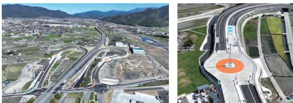
東温スマートIC、小郡鳥栖南スマートICの出入口には「環道型退出路」を採用し、ランプ形状をコンパクト化
