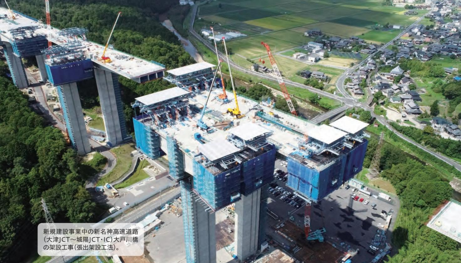
新規建設事業中の新名神高速道路（大津JCT～城陽JCT・IC）大戸川橋の架設工事（張出架設工法）。
