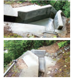
強化後の縦溝と集水ます
