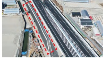
徳島南部道本線横の津波避難場所(赤枠内)
