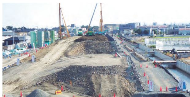
建設発生土の受け入れ
