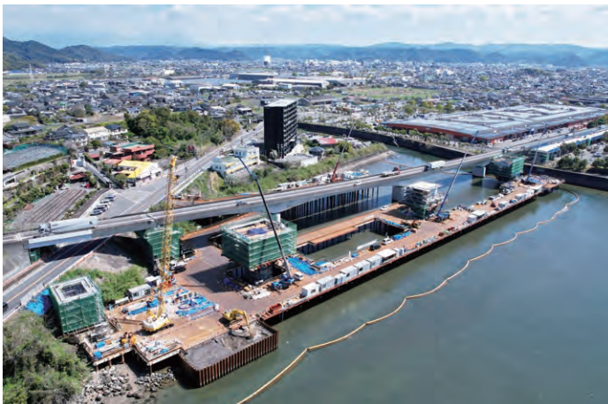
東九州道(隼人道路) 隼人東IC～隼人西IC 清水川橋下部工工事
