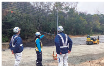
支障移転の現場打合せの様子
