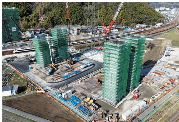
新名神 八幡京田辺JCT・IC～高槻JCT・IC 高槻高架橋 下部工工事
