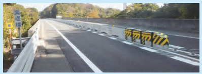
センターブロック
