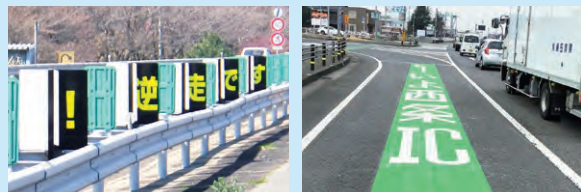
(左) 逆走車両に対する防眩板応用注意喚起 (右) 一般道接続部のカラー舗装 (逆走・誤進入防止)
