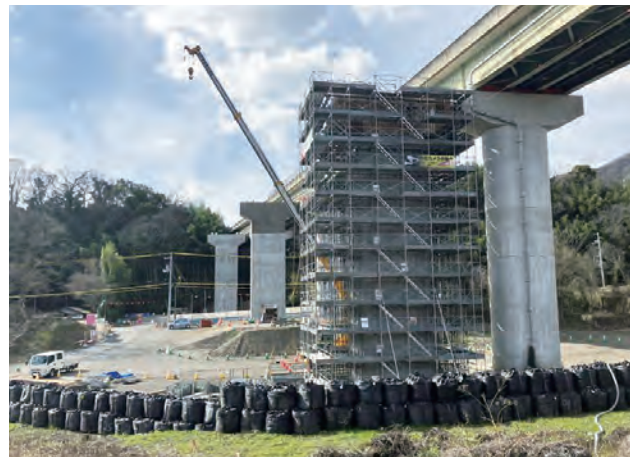
徳島道 脇町IC～美馬IC 脇大谷川橋下部工工事
