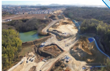
神戸西バイパス 櫛谷工事
