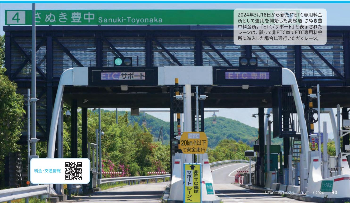
2024年3月18日から新たにETC専用料金所として運用を開始した高松道 さぬき豊中料金所。「ETC/サポート」と表示されたレーンは、誤って非ETC車でETC専用料金所に進入した場合に通行人に案内するレーン。
