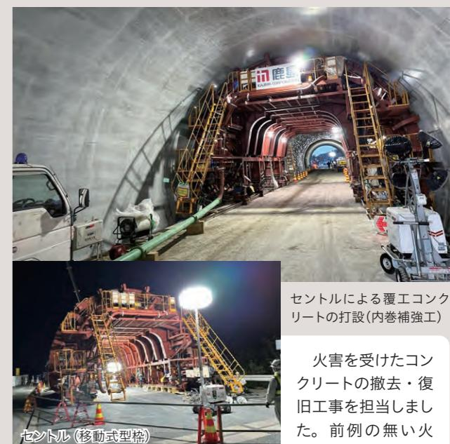
セントルによる覆工コンクリートの打設(内巻補強工)
