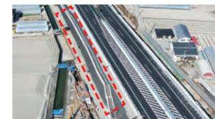
降雨災害時ののり面被害は、排水構造物が直接関与した崩壊が約半数を占め、さらに、その約半数が縦溝や集水ます等の合流部で発生。これらを踏まえ、高速道路リニューアルプロジェクト(P.15-16)の中で、のり面の排水構造物の大規模修繕に取り組んでいます。
