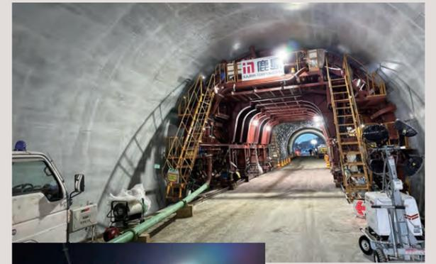
セトルによる覆工コンクリートの打設(内巻補強工)
