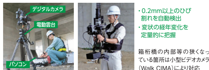
Auto CIMA Systemを使った点検の様子
