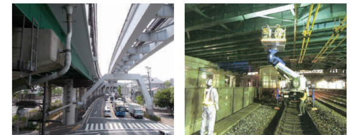
鉄道及び重交通路線と近接する区間
