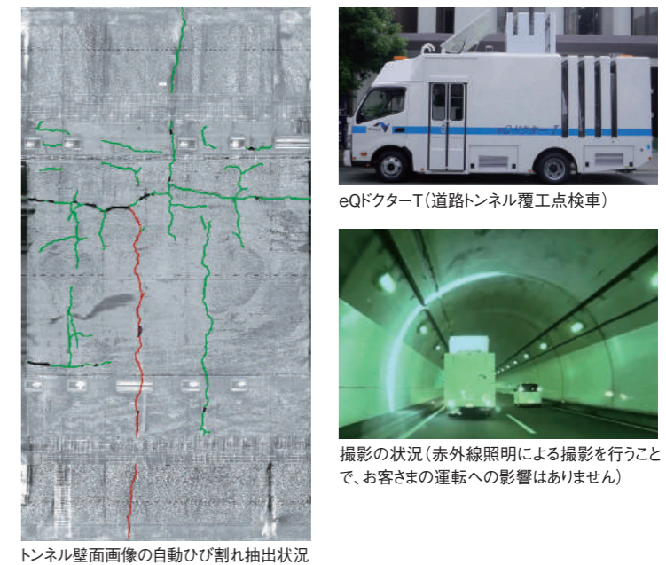
トンネル壁面画像の自動ひび割れ抽出状況
