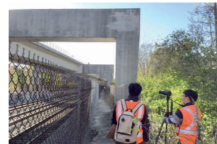
NEXCO-West USA, Inc. 近接目視困難箇所の構造物点検
