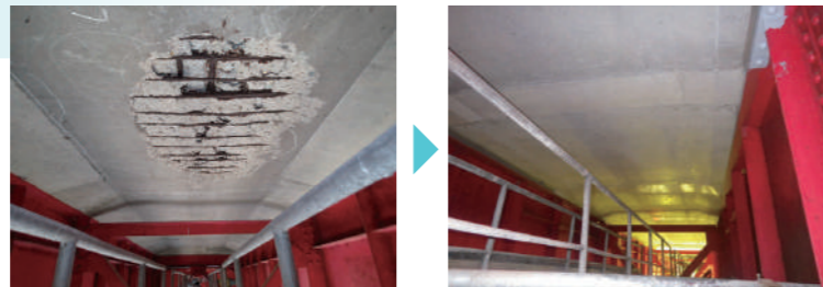
床版取替工事（左：施工前、右：施工後）
