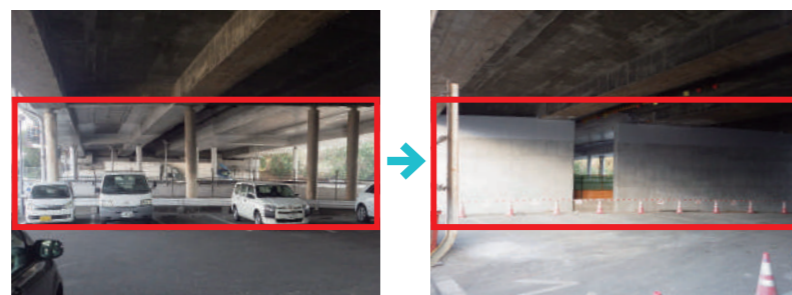
名神高速道路 島田橋 (左:補強前の橋脚、右:補強後の橋脚)
