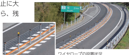
ワイヤロープの設置状況
