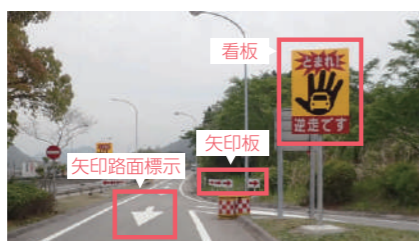
休憩施設入口部での逆走対策例
