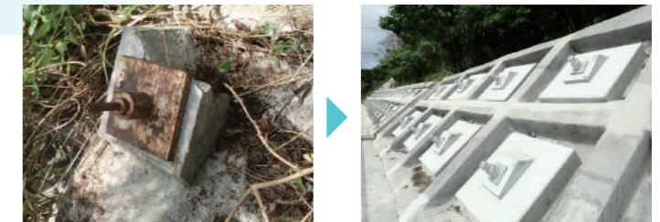
グラウンドアンカー設置工事（左：施工前、右：施工後）
