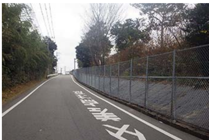
シカ侵入対策（フェンスの嵩上げ）
