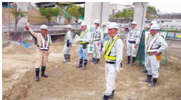
受発注者で実施する安全パトロールの様子
