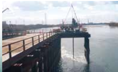
淀川橋構造物調査工事の様子
