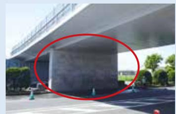
熊本ICランプ橋の様子(左:地震の影響で傾いた橋脚、右:補強後の橋脚)
