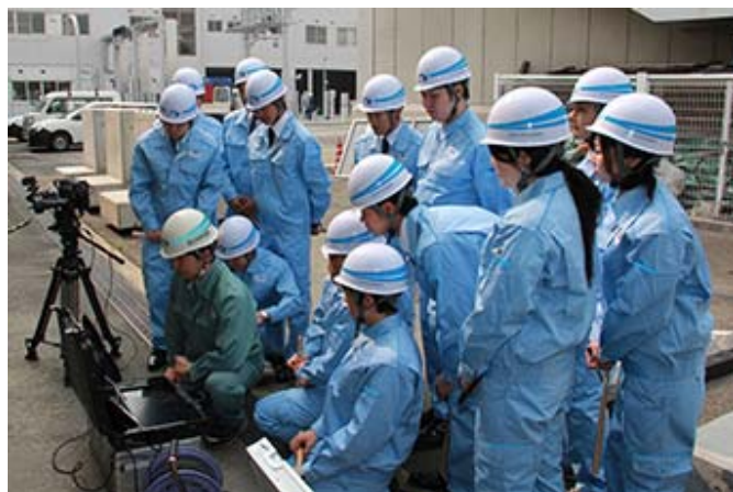
auto CIMA Systemによる撮影・診断
