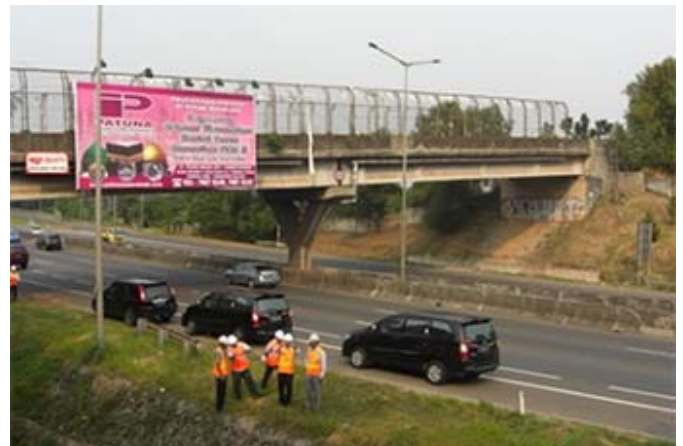
ビンタロー・スルボン道路全景
