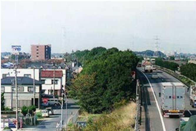
名神高速道路 盛土樹林化の様子
