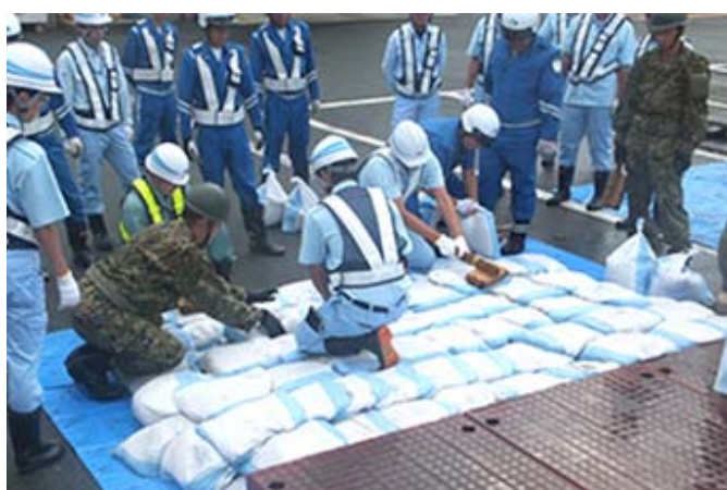
土のうによる段差修正
