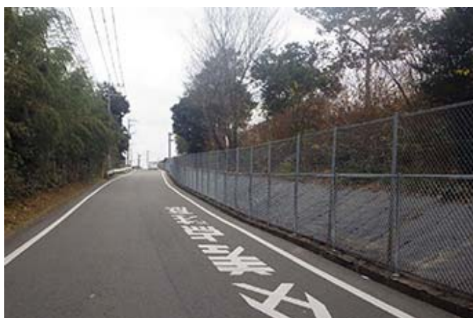
シカ侵入対策（フェンスの嵩上げ）
