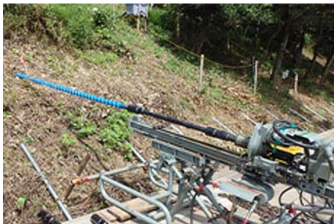
SDPR工法の施工状況
