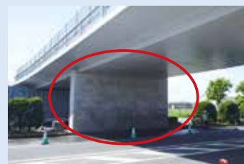
熊本ICランプ橋の様子(左:地震の影響で傾いた橋脚、右:補強後の橋脚)
