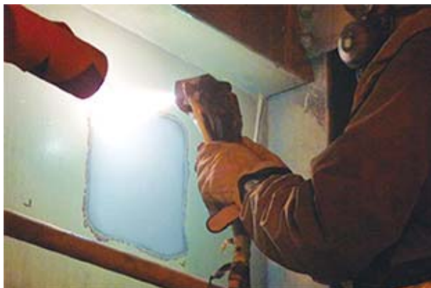
金属溶射作業の様子
