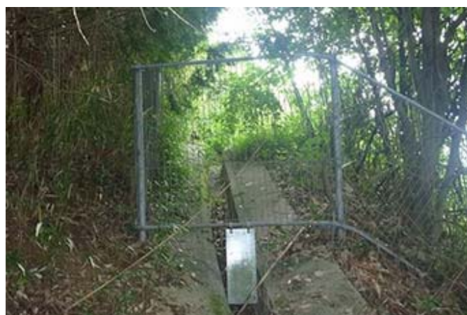
小中型動物侵入対策（排水溝の閉塞）
