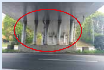
熊本ICランプ橋の様子(左:地震の影響で傾いた橋脚、右:補強後の橋脚)
