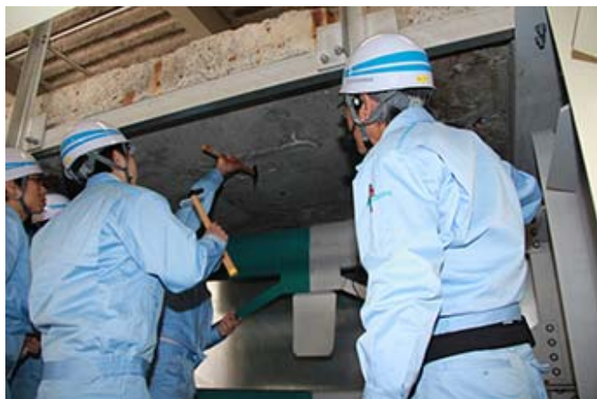
実構造物を活用した打音点検
