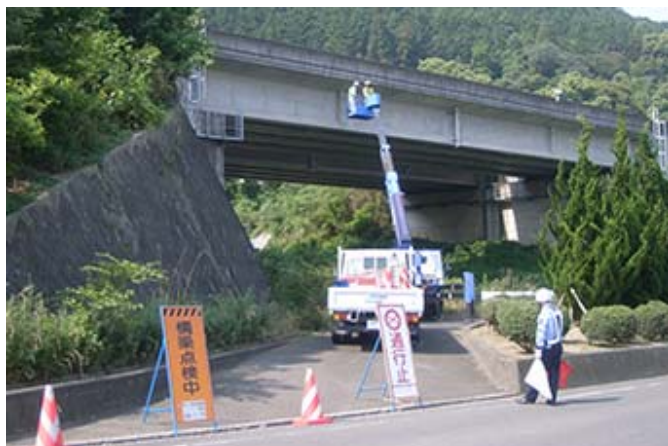
橋梁点検業務
