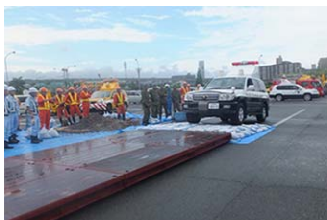
修正した段差を走行する車両
