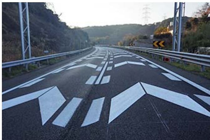
矢羽板や路面標示の施工例
