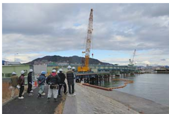
道路工学に関する講義 (現場見学の様子)
