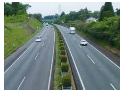
九州道4車線開放後の様子
