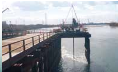
淀川橋構造物調査工事の様子
