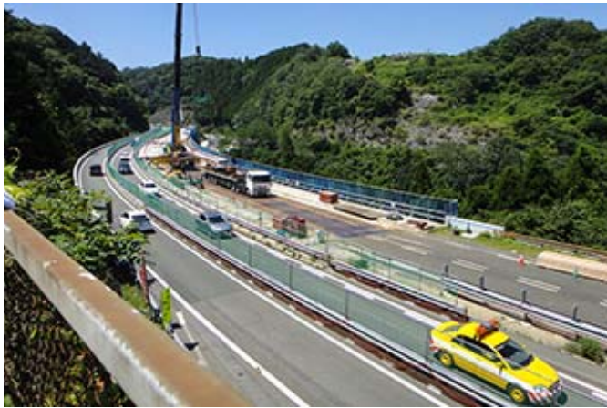
大規模更新・大規模修繕の様子
