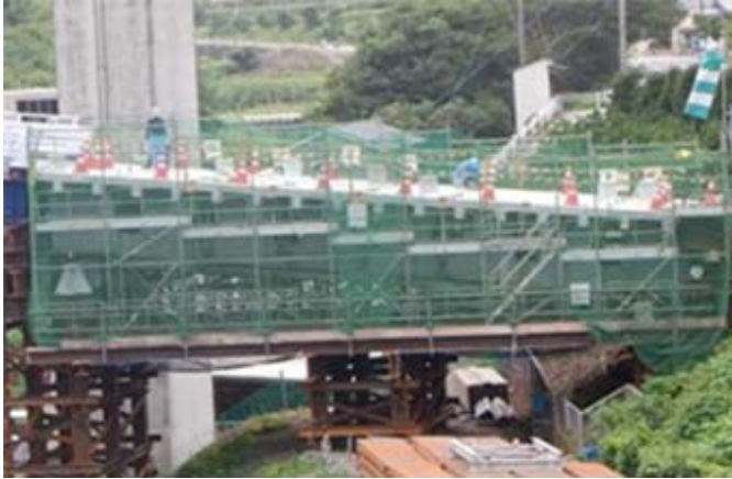
工事用道路での実証橋（長崎自動車道）
