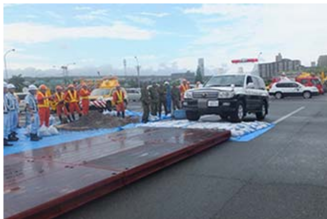
修正した段差を走行する車両
