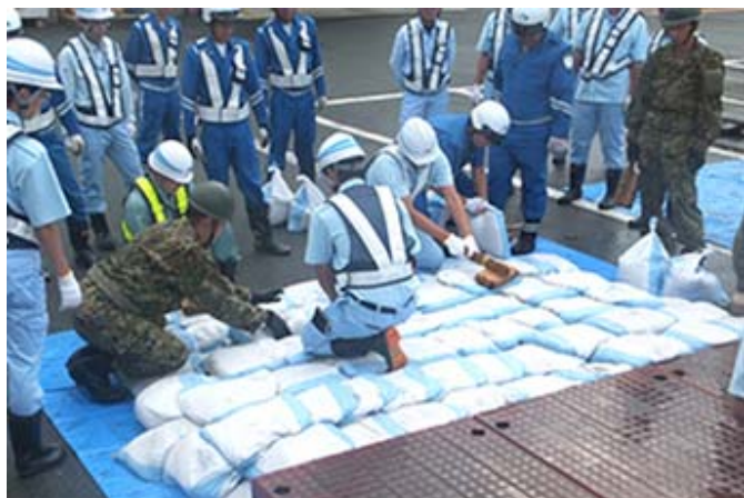
土のうによる段差修正
