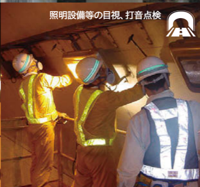
橋梁点検車からの目視、打音点検
