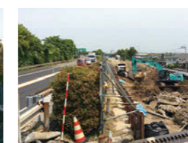
対面交通で仮復旧した崩落箇所
