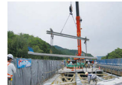
プレキャストPC床版への取り替え工事
