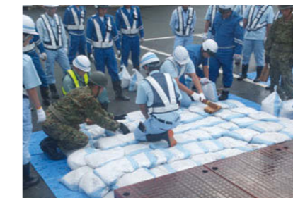
防災訓練(段差補修訓練)の様子
