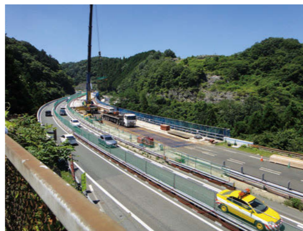
床版の取替工事とそれに伴う対面交通規制
