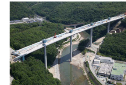
新名神 武庫川橋の建設状況
