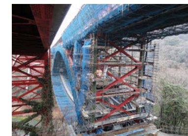
耐震補強工事を計画的に実施しています
