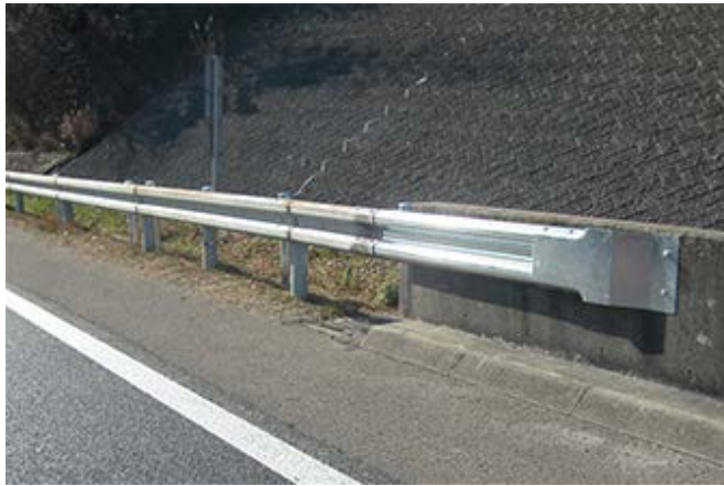
ガードレールの連続化の施工例
