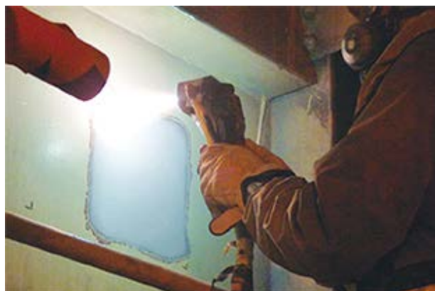
金属溶射作業の様子
