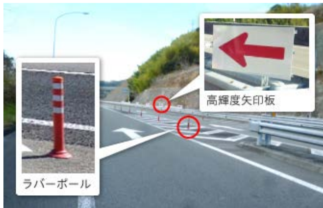
本線合流部の例(16カ所の施工例)
