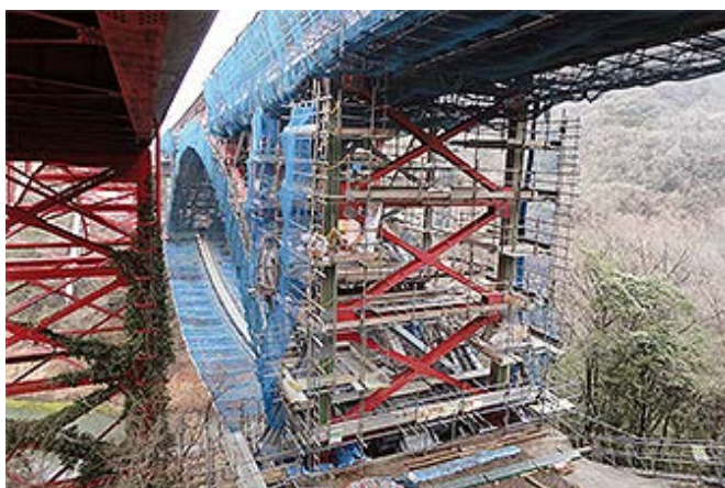
耐震補強工事を計画的に実施しています
