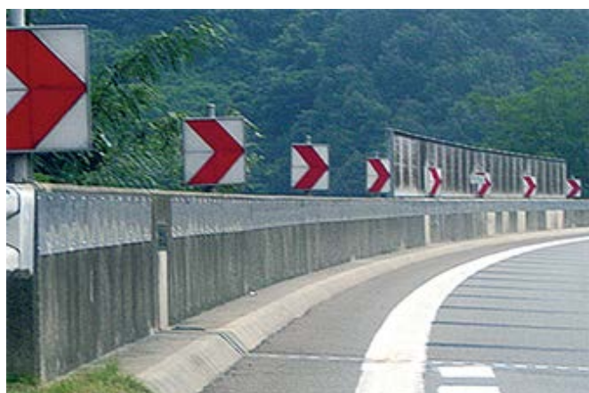
矢羽板の施工例
