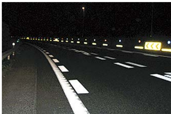
高輝度(凹凸)レーンマーク
