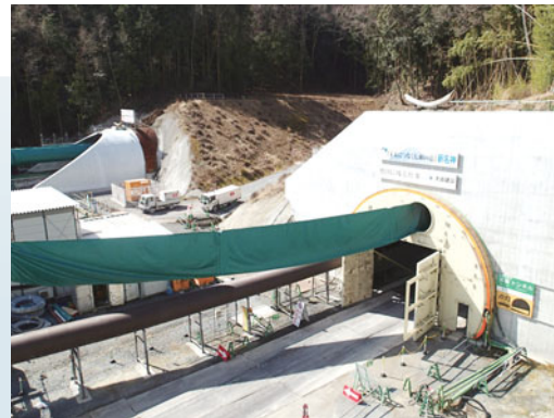
2 工事中の箕面トンネル
