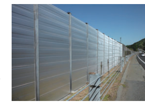
リサイクルできるアルミ製の遮音壁
