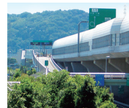
騒音を防止する遮音壁
