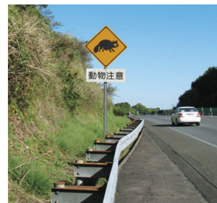
野生動物の横断について、ドライバーへ注意を促す標識
