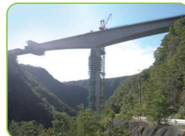
川下川下流部において、橋脚高さ95m 橋長300mの橋梁を工事中です。
