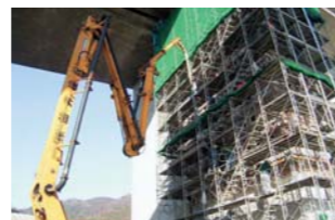
橋脚の耐震補強工事
