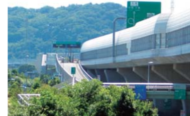
騒音を防止する遮音壁
