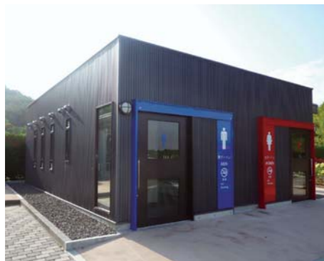
ユニット式お手洗い(山陽自動車道 福山SA)
