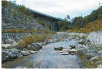
水中生物の移動経路を確保した準人川(新名神高速道路)
