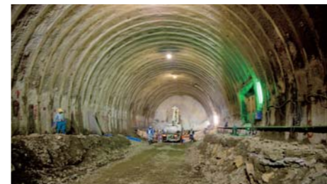
騒音・振動に細心の注意を払いながら掘削を実施
