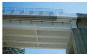
国道と交わる重要交差点箇所に繊維シートを貼付しています
