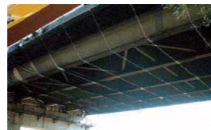
はく落防止ネットの設置で第三者被害ゼロを目指します
