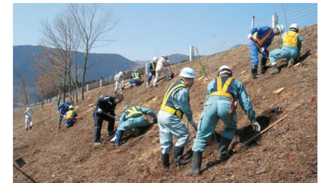
地域住民と一体となって盛土のり面を維持管理
