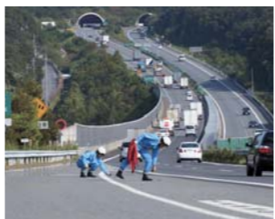
路上障害物の排除
