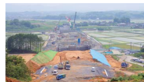
工事が着々と進む盛土区間
