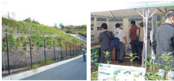
高速道路に植栽した地域性苗木(新名神高速道路)
