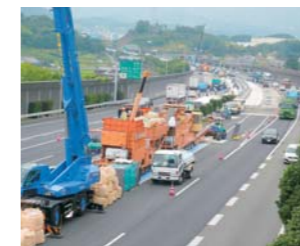
中国自動車道での集中工事規制
