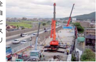
※路面を支えるコンクリート版
