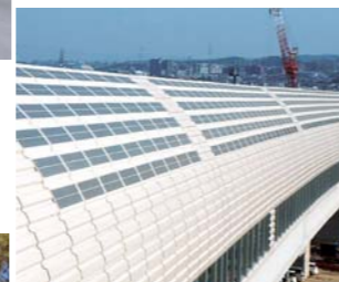
遮音壁一体型太陽光発電 (第二京阪道路)
