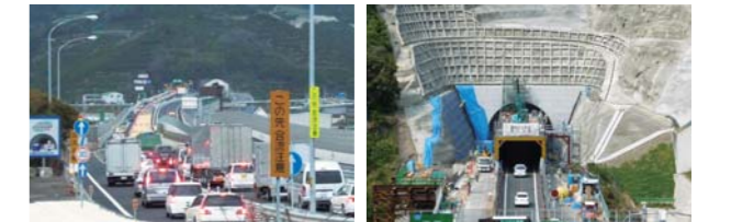
工事中の有田インター上り線合流部
