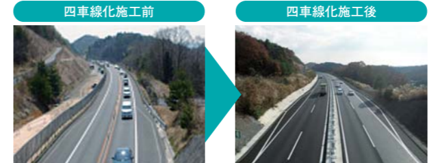
四車線化工事中の岡山自動車道
