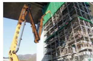
橋脚の耐震補強工事
