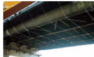
はく落防止ネットの設置で第三者被害ゼロを目指します
