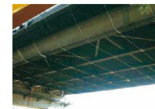
はく落防止ネットの設置で第三者被害ゼロを目指します
