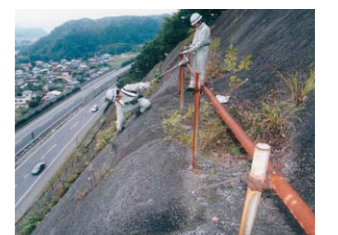
のり面の点検状況
