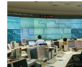
道路管制センター
