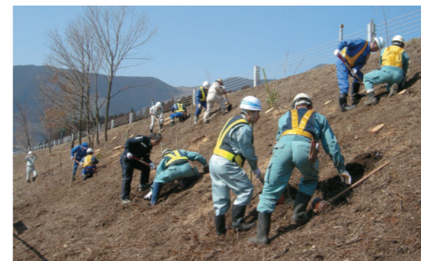
地域住民と一体となって盛土のり面を維持管理
