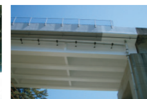
国道と交わる重要交差箇所に繊維シートを貼付しています
