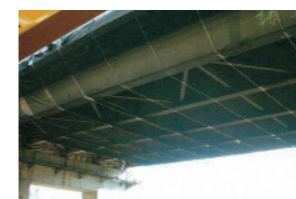
はく落防止ネットの設置で第三者被害ゼロを目指します
