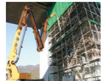
橋脚の耐震補強工事
