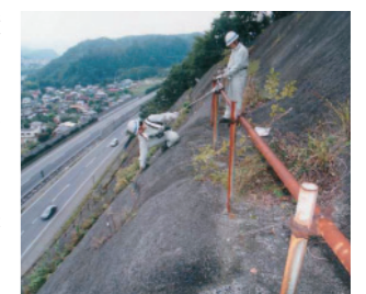
のり面の点検状況
