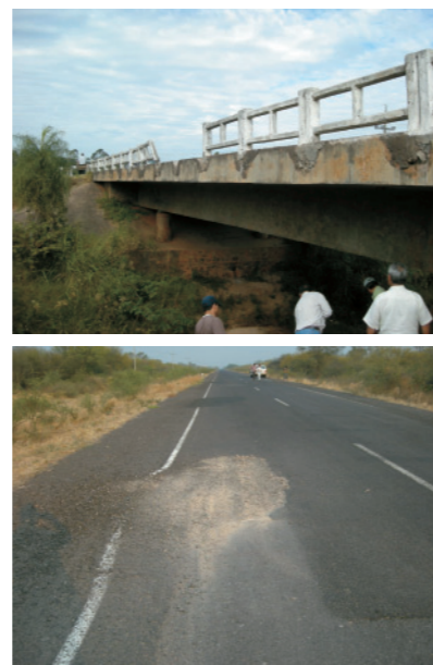
パラグアイの道路状況（上が橋梁、下が舗装）
