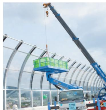
クレーンで部材を吊り上げ高さ8メートルの遮音壁を設置
