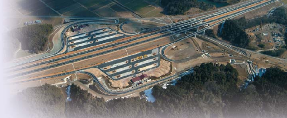
新名神高速道路甲南インターチェンジ
