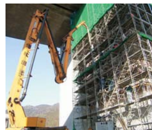
橋脚の耐震補強工事
