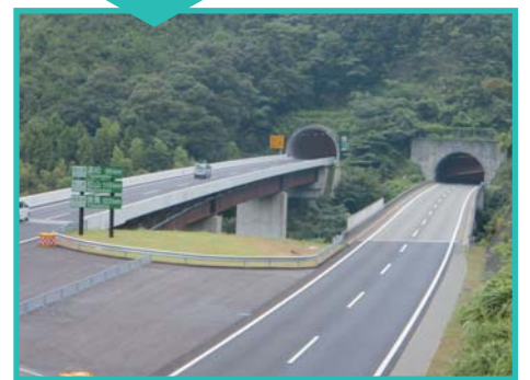
4車線化が実現した高知自動車道
