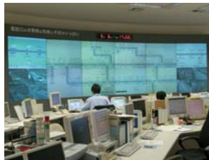
道路管制センター
