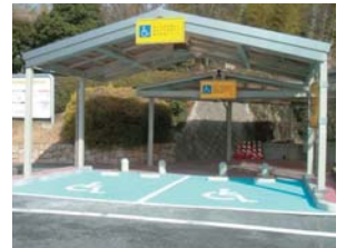
身体障がい者駐車スペース
