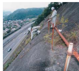
のり面の点検状況
