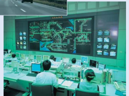
道路管制センター
