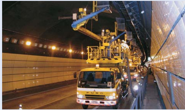
測定車を用いたトンネル水噴霧設備の放水点検
