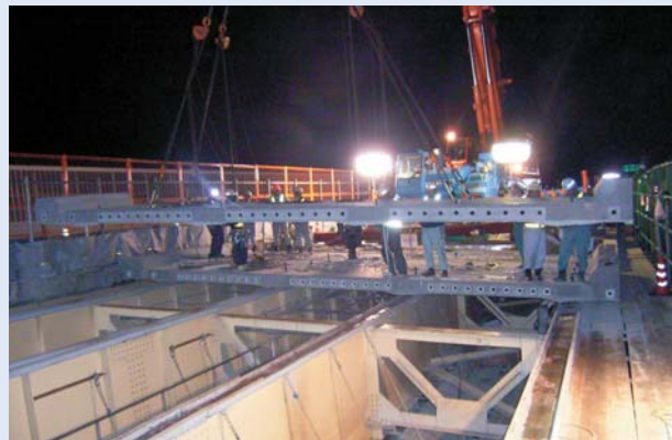
プレキャスト床版を用いた橋梁床版補修事業
