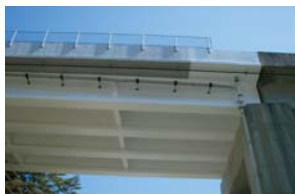
国道と交わる重要交差箇所繊維シートを貼付しています
