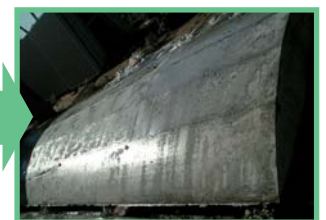
新開発の中流動覆工コンクリート
