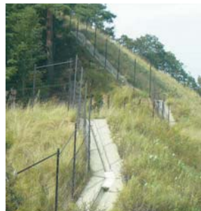
動物侵入防止柵の設置
