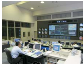
道路管制センター（施設制御部門）
