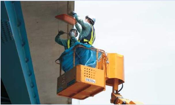
高所作業車上での橋梁たたき点検
