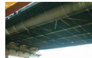
はく落防止ネットの設置で第三者被害ゼロを目指します
