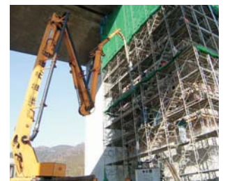
橋脚の耐震補強工事
