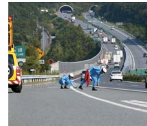
路上障害物の排除
