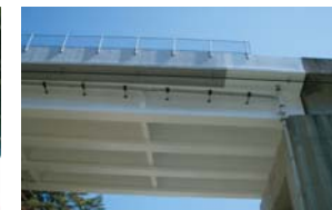
国道と交わる重要交差箇所に繊維シートを貼付しています
