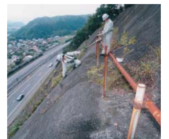
のり面の点検状況
