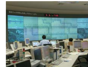
道路管制センター
