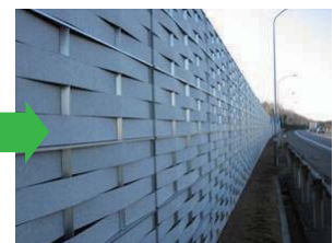
走行景観に配慮した遮音壁
