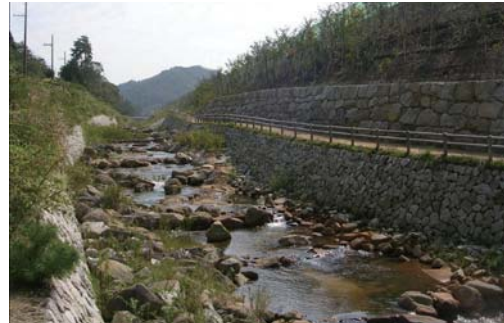
隼人川(新名神高速道路/滋賀県信楽町)
