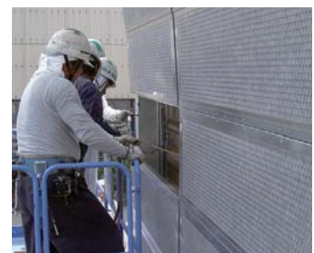
管理に配慮した遮音壁
