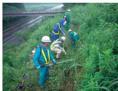
のり面小段排水溝清掃
