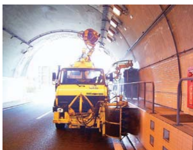
トンネル側壁清掃
