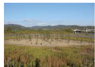
山陽自動車道 (福山西インターチェンジ) 植樹直後
