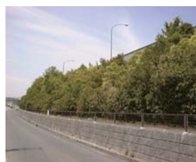
阪和自動車道 (大阪府堺市付近) 植樹後約10年
