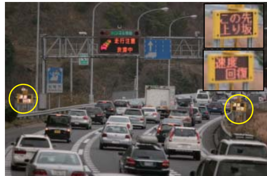
LED標識による速度低下注意喚起(速度回復の情報提供) (中国自動車道・宝塚IC～西宮山口JCT間上り線)
