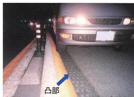
凹凸型路面標示工
