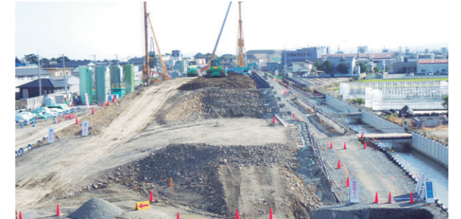
建設発生土の受け入れ
