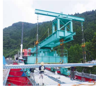
中国自動車道 浦石橋
