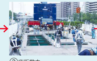
②床版撤去
