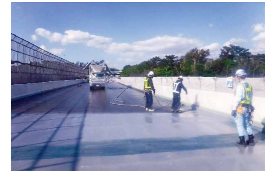
沖縄自動車道 福地川橋
