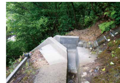
修繕後の集水ますと縦溝
