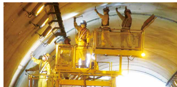
構造物の点検
