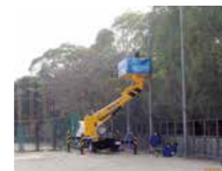
ネットに絡みついたツタの除去の様子
