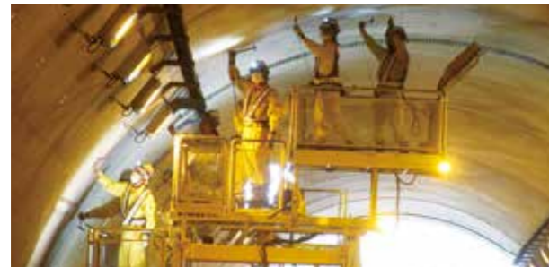
構造物の点検
