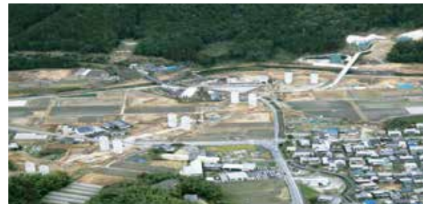
建設中の新名神高速道路 宇治田原第二高架橋
