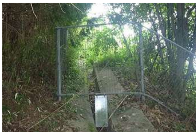
小中型動物侵入対策（排水溝の閉塞）
