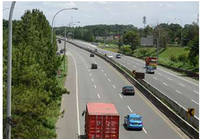
BSD道路全景
