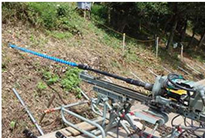
SDPR工法の施工状況
