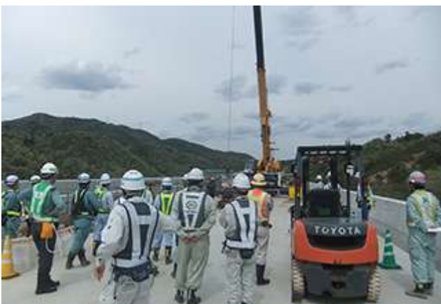
受発注者で実施する安全パトロールの様子
