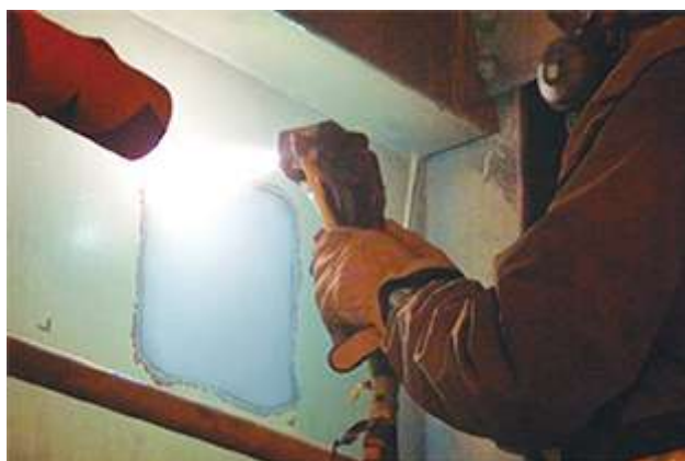
金属溶射作業の様子
