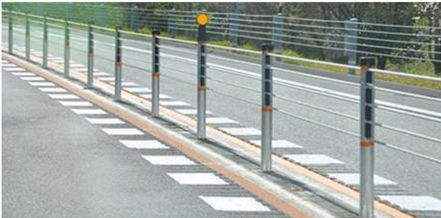
ワイヤロープの設置状況
