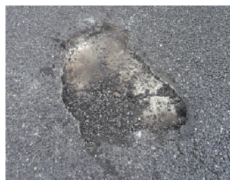
上面 舗装の損傷状況
