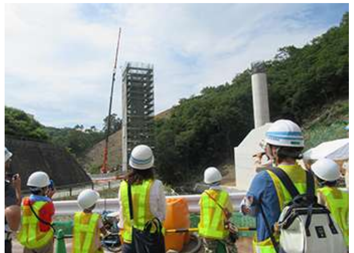
播磨新宮IC工事_建設現場見学
