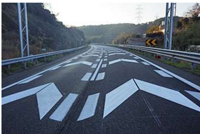
矢羽板や路面標示の施工例
