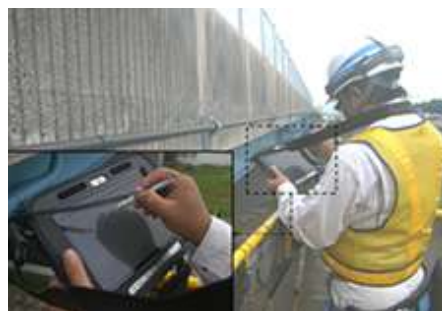
タブレットでの点検記録
