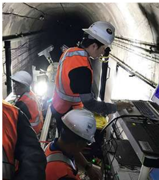
地下鉄トンネル点検（アメリカ）
