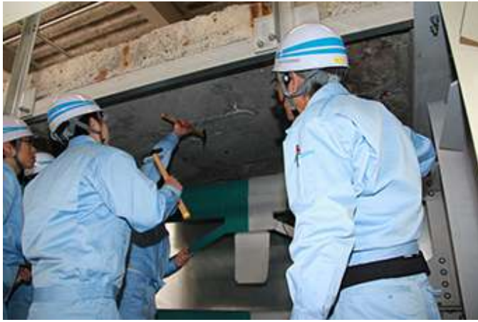
実構造物を活用した打音点検
