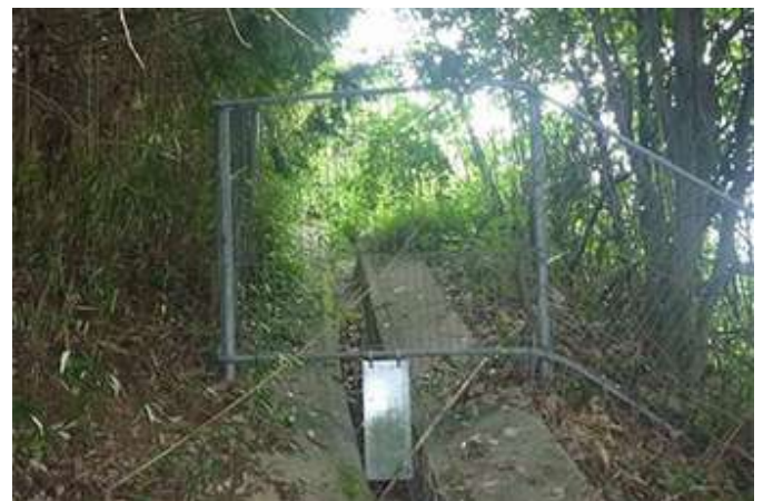
小中型動物侵入対策（排水溝の閉塞）
