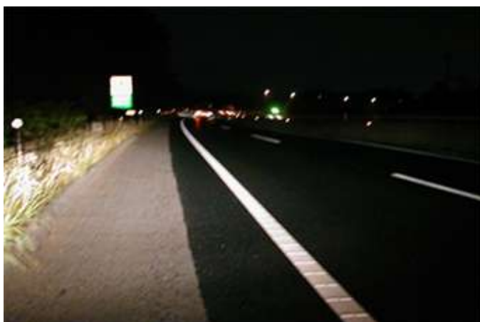
高輝度（凹凸）レーンマーク
