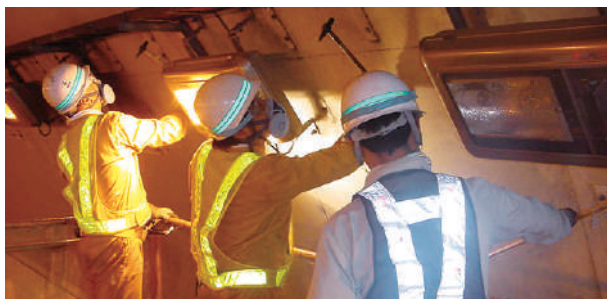
構造物の点検
