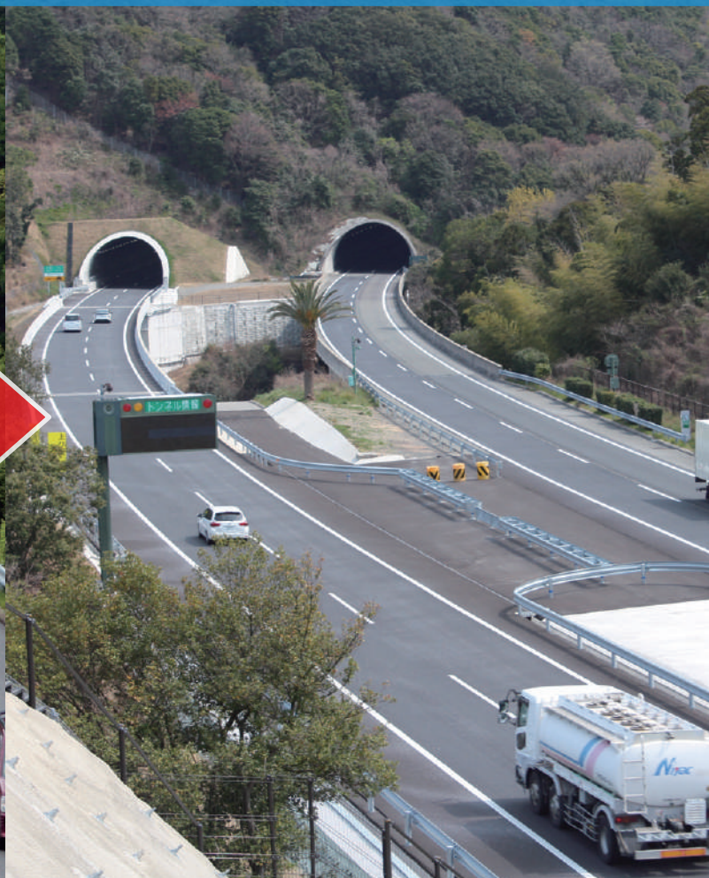
4車線化完了後の状況／高松道(板野IC～引田IC)
