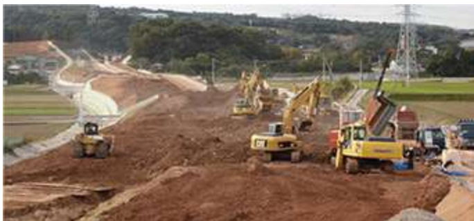
他の建設工事等で発生した土砂を受け入れ、 利用しています
