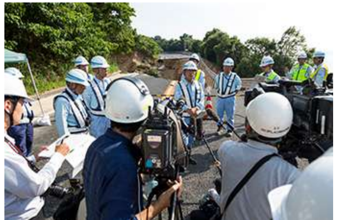
広島呉道路復旧現場公開
