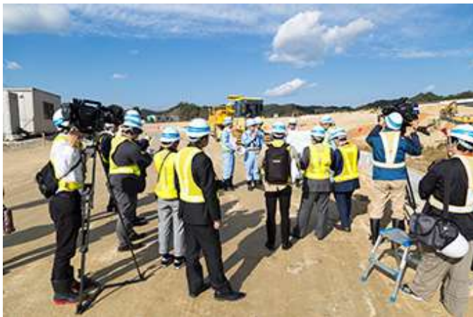
和歌山南スマートIC建設現場公開
