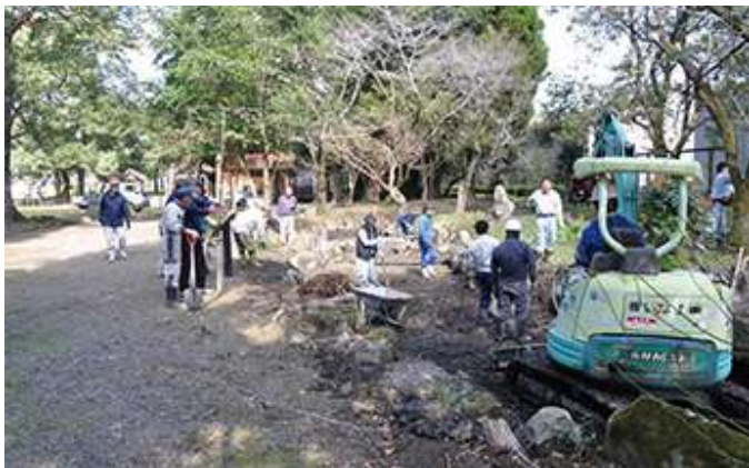
庭園復旧の様子
