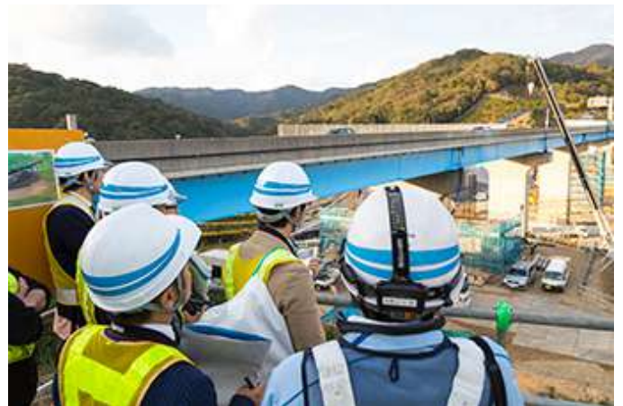
和歌山南スマートIC建設現場公開
