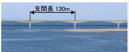
浚渫を最小とするために、橋桁架設時の浚渫が不要となる架設工法を採用し、その最大スパンを適用したコンクリート桁橋<sup>※2</sup>。
