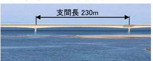
橋脚による流況への影響(地形変化量)を最小とするために、桁橋の最大スパンを適用した鋼桁橋
