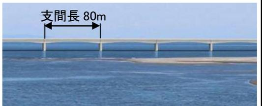
一般的に経済性に優れたスパンのコンクリート桁橋。(阿波しらすぎ大橋の一般部と同程度の支間長)
